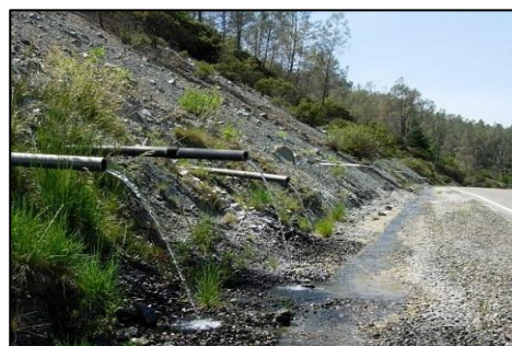
Figure 2.10 Drainage de talus par barbacanes
