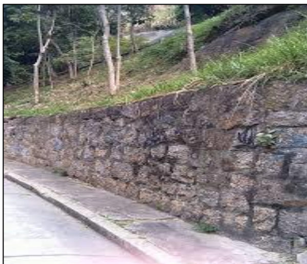
Figure 2.12 Mur de soutènement.
