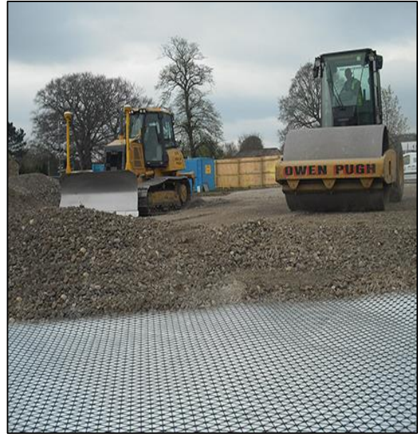
Figure 3.8 Mise en place et compactage du remblai
