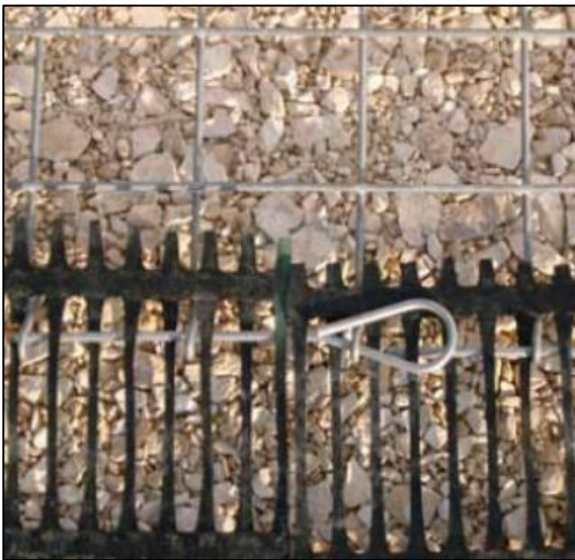
Figure 3.9 Mise en place de la nappe de renforcement attaché aux blocs modulaires
