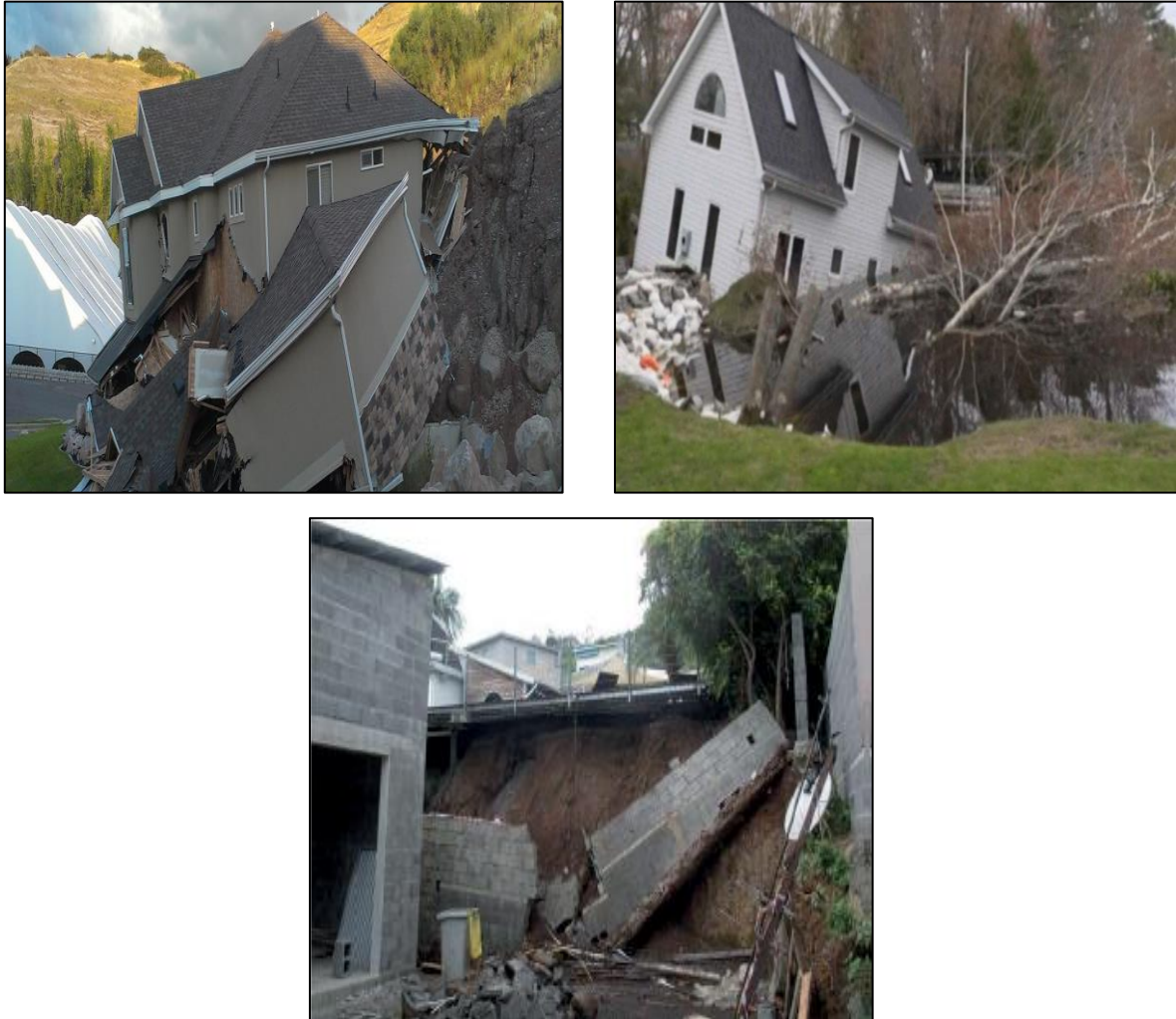
Figure 2.8 Fissuration des bâtiments
