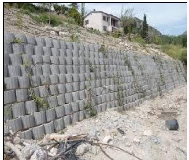
Figure 2.12 Mur de soutènement.
