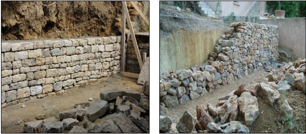
Figure 2.14 Mur en pierres sèches
