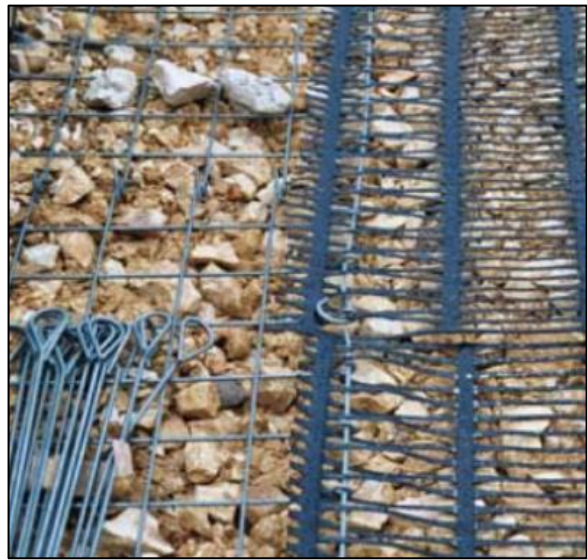
Figure 3.9 Mise en place de la nappe de renforcement attaché aux blocs modulaires
