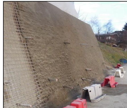
Figure 2.11 Principe du clouage et exemple de réalisation
