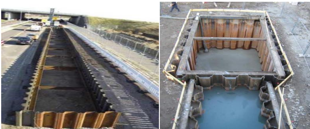
Figure II.13. Palplanches métalliques.
