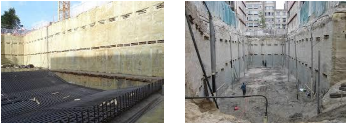
Figure II.27. Paroi en soilmix (paroi CSM).
