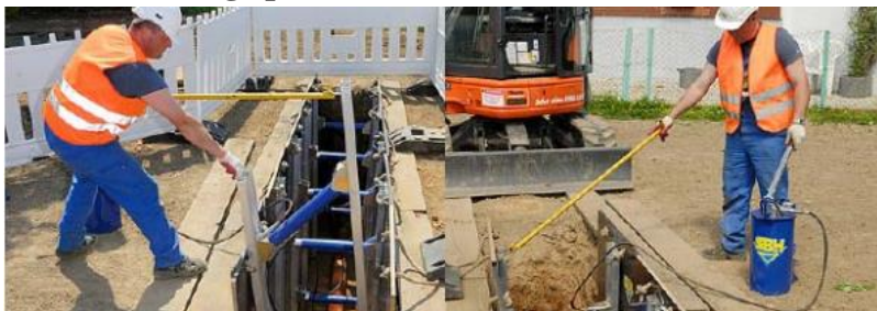
Figure II.5. Cadres verticaux (avec ceinture hydraulique)
