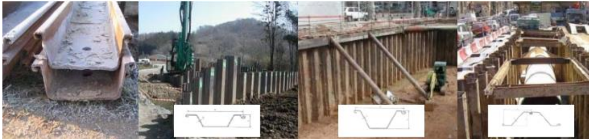
Figure II.12. Palplanches métalliques.
