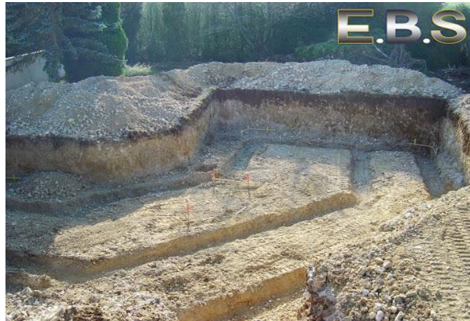
Figure I.1. Fouille en rigole
