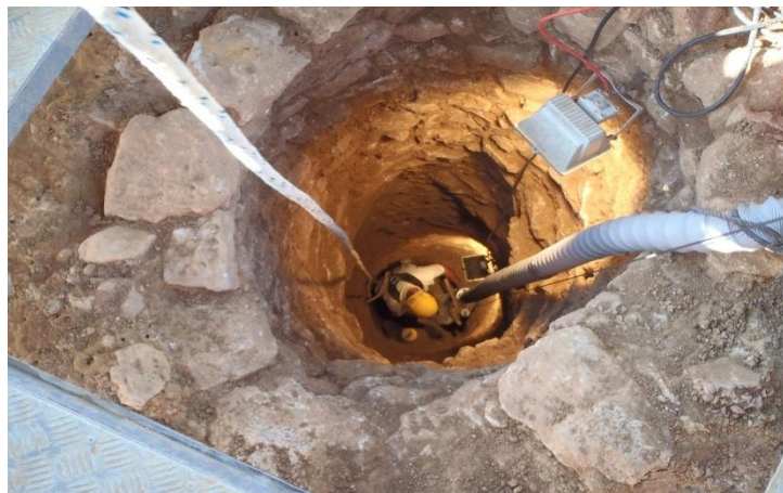
Figure I .3. Fouille en puit
