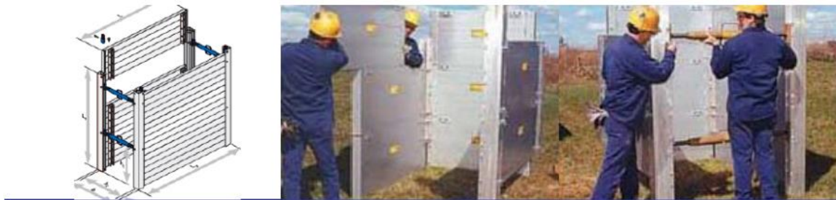
Figure II.6. Panneaux préfabriqués légers
