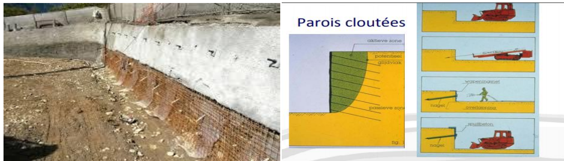
Figure II.16. Parois cloutée.
