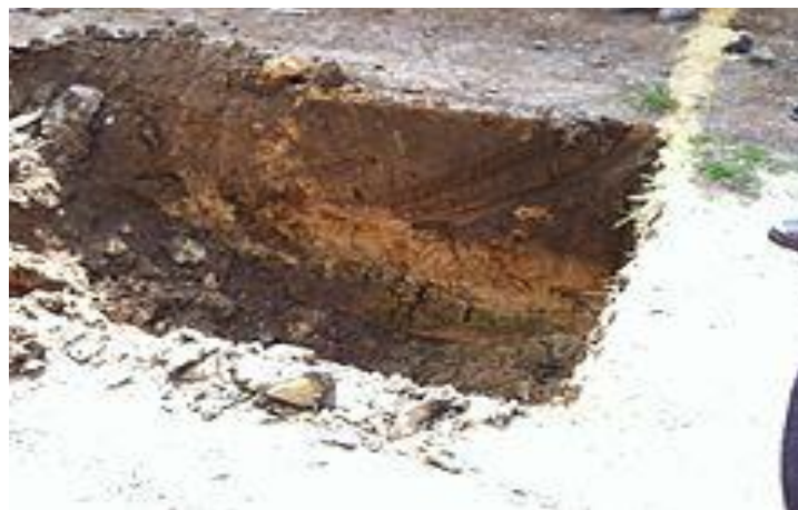
Figure I.2. Fouille en tranchées
