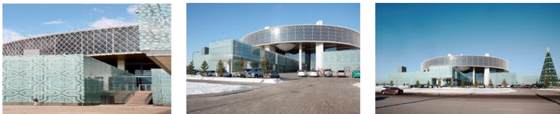
Figure 45 : Photos d'extérieur de Schoolchildren's Palace
