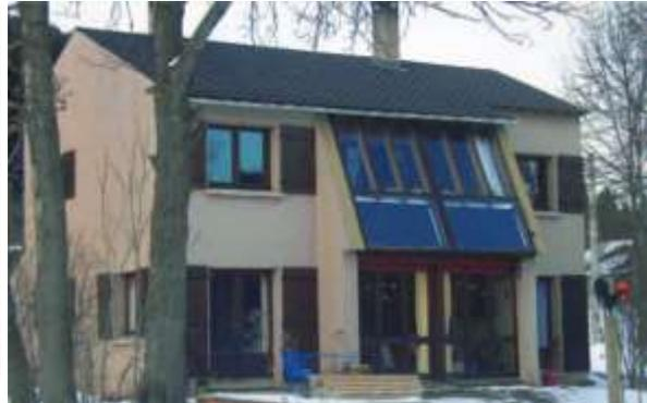
Figure 44: Le capteur a une fonction d'allège et d'auvent.
