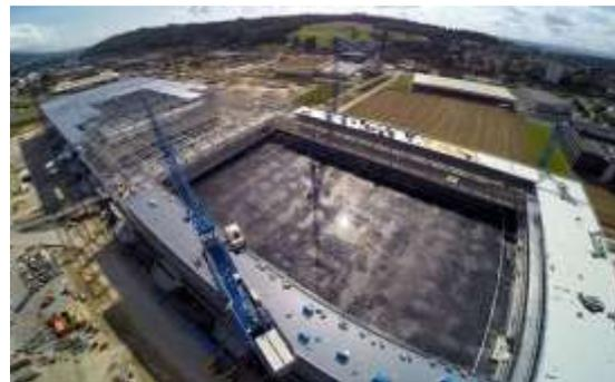
Figure 143 : Isolation par Bitume du stade.
