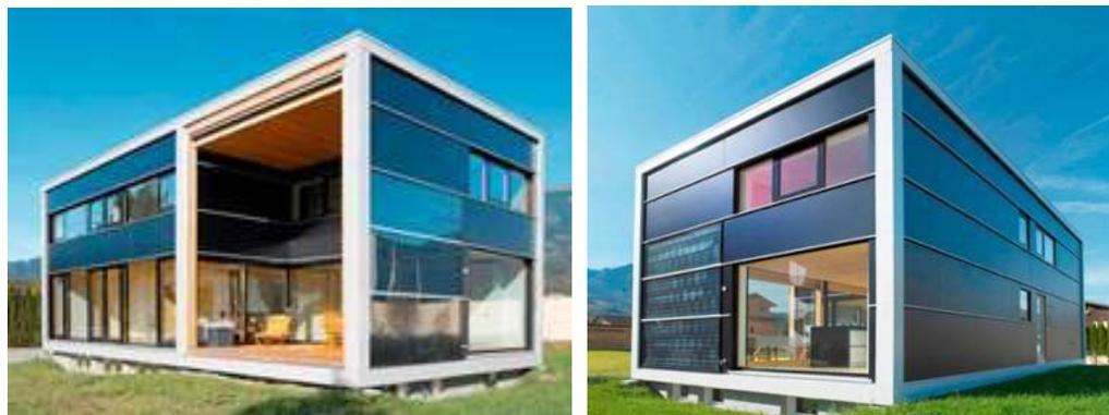
Figure 29: Panneaux solaires thermiques vitrés opaques bleus foncés, d'une fraction solaire de 90%.
