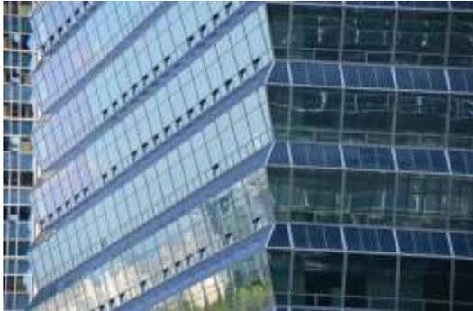
Figure 43: système photovoltaïque intégré au décrochement du bâtiment.
