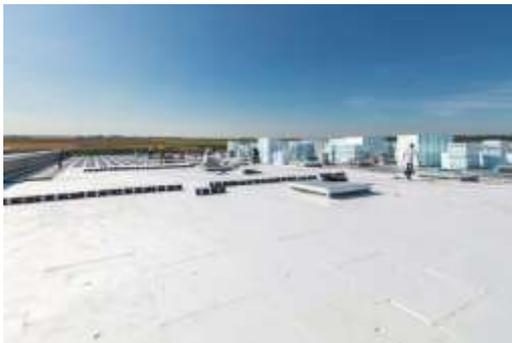
Figure 142 : Etanchéité de la toiture.
