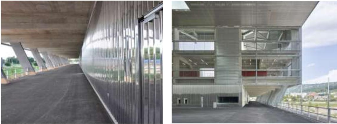
Figure 128 :Les panneaux profilés en inox et en aluminium.
