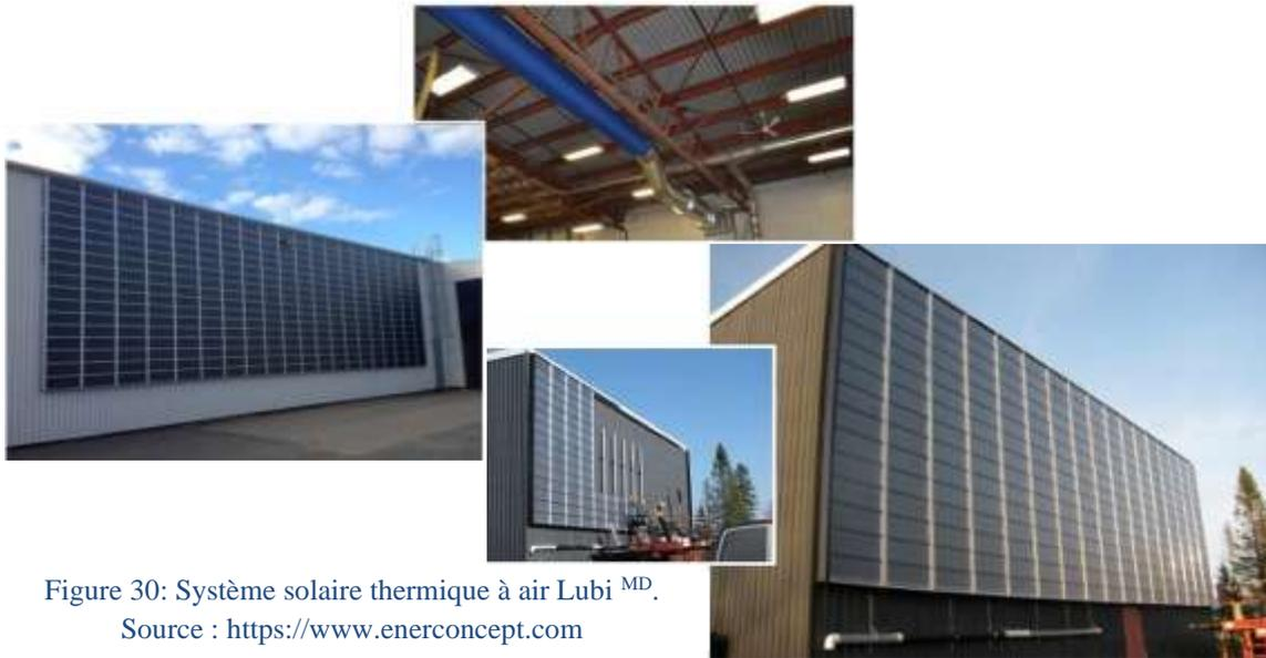
Figure 30: Système solaire thermique à air Lubi<sup>MD</sup>.
