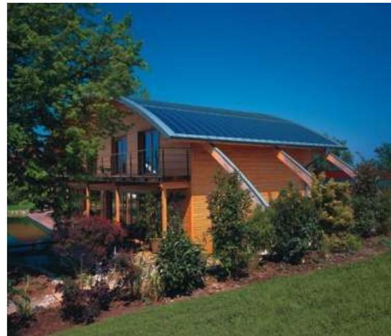
Figure 54: Système solaire photovoltaïque de silicium amorphe intégré à la toiture
