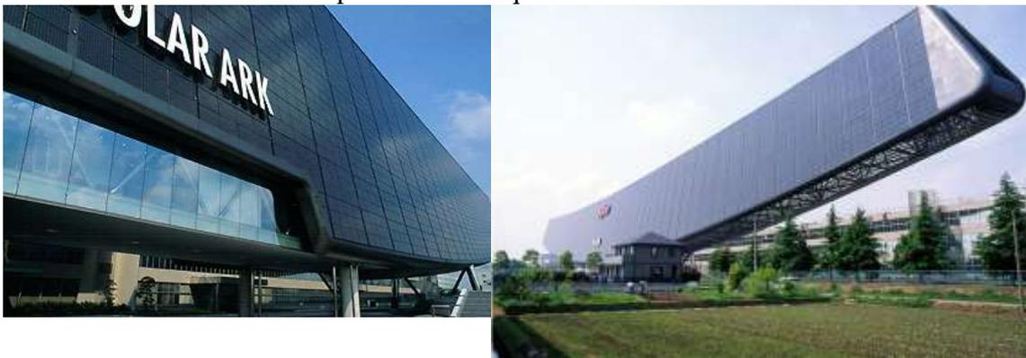
Figure 52: Panneaux solaires photovoltaïques de silicium monocristallin intégrés au bâtiment.
