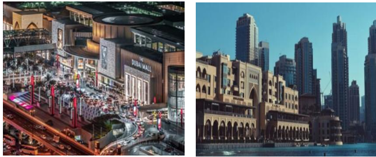
Figure 80 : Les façades du Dubaï Mall.
