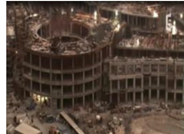
Figure 85: Les murs de support du Dubaï Mall. Les joints entre les bâtiments. L'ensemble structurel du Dubaï Mall.
