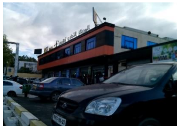
Figure 45: Le centre commercial « Oasis Mall » (Guelma).
