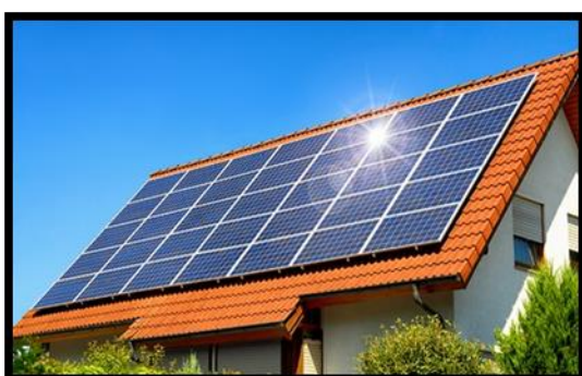
Fig,34: panneau solaire photovoltaïque
