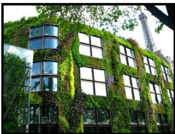
Fig,29: façade végétalisée
