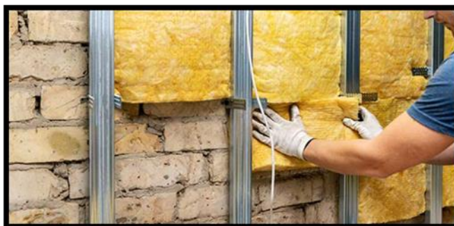
Fig,26; l'isolation des murs
