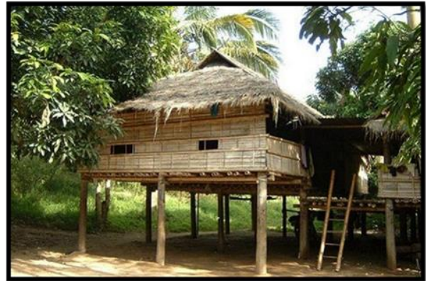
Fig.46: maison vernaculaire sur pilotis
