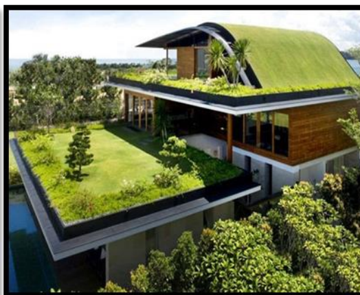
Fig,30: toiture végétalisée
