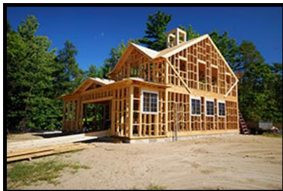
Fig. 7 : Maison à ossature en bois (extérieur)
