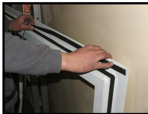
Fig. 25 : isolation des fenêtres
