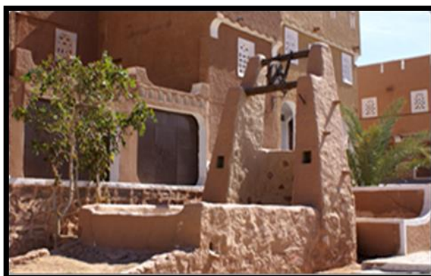
Fig,94:La protection solaire
