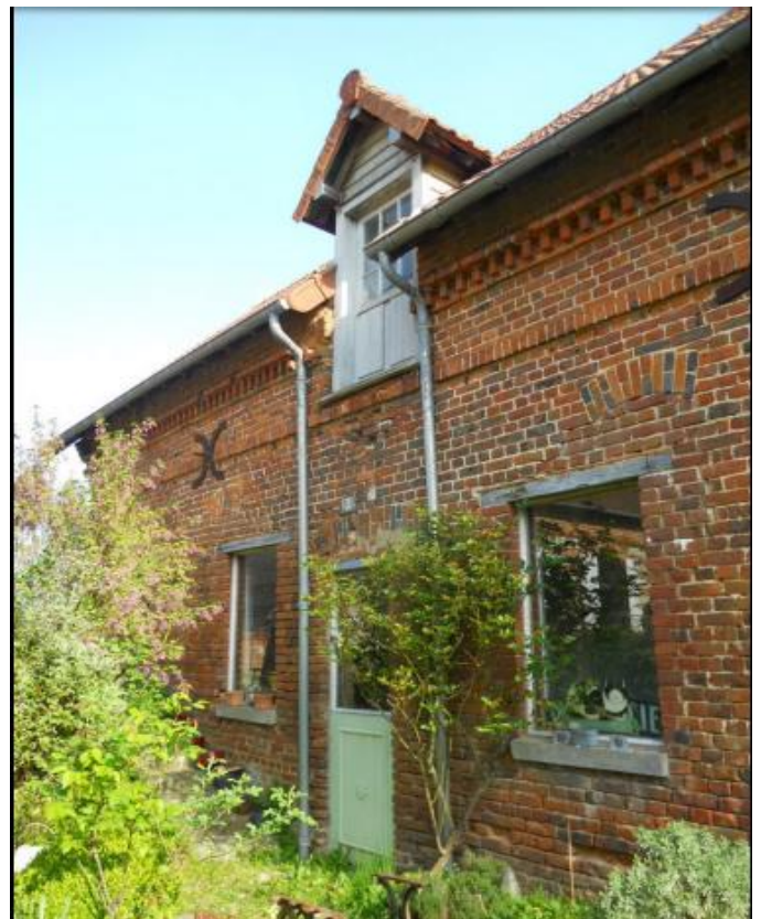
Figure 17 : les revêtements de façade
