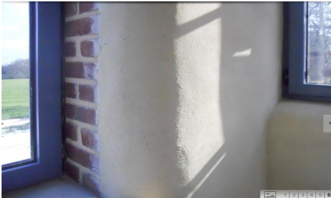
Figure 16 : Isolation des murs intérieur
