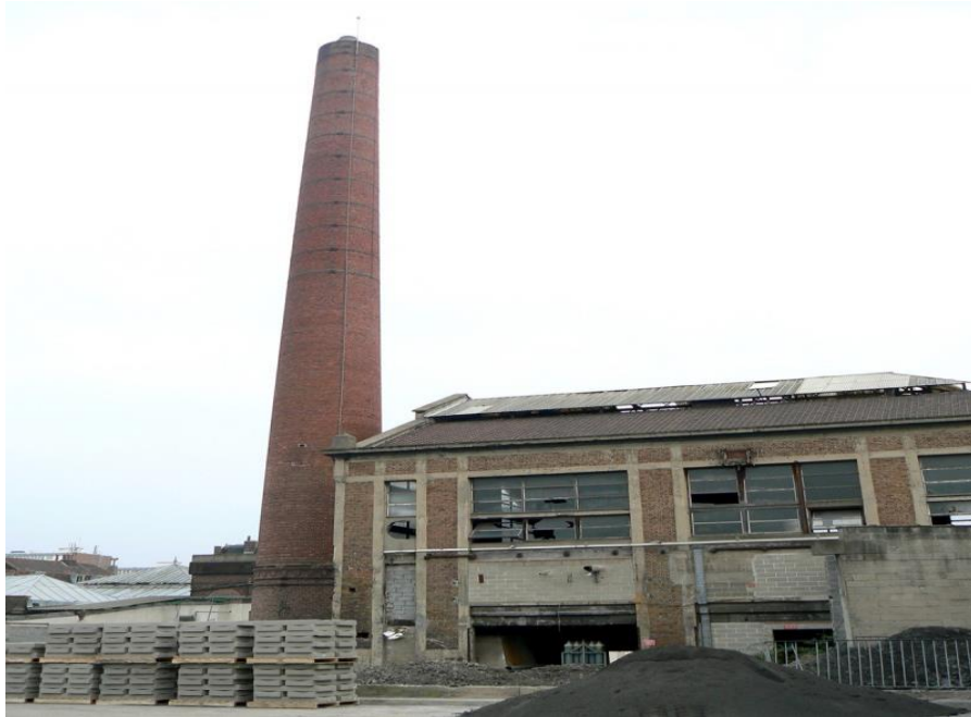
Figure 20: grande cheminée en briques
