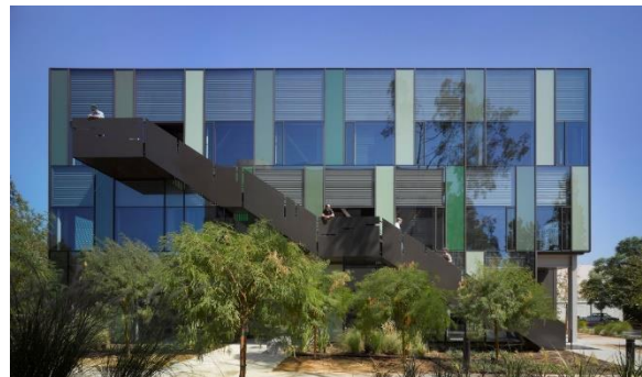
Figure 171: façade ouest de centre de recherche W et L
