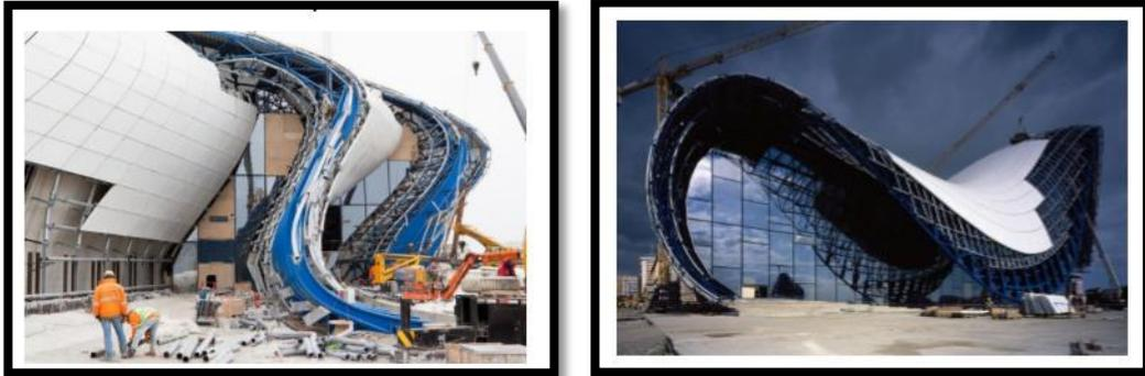
**Figure72** : Le revêtement de la structure métallique
