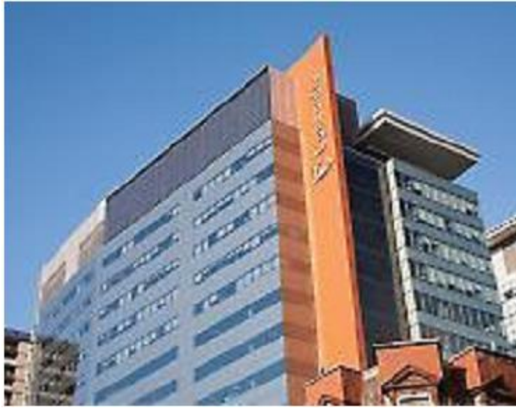
Figure 68: intégration PV/T sur façade
