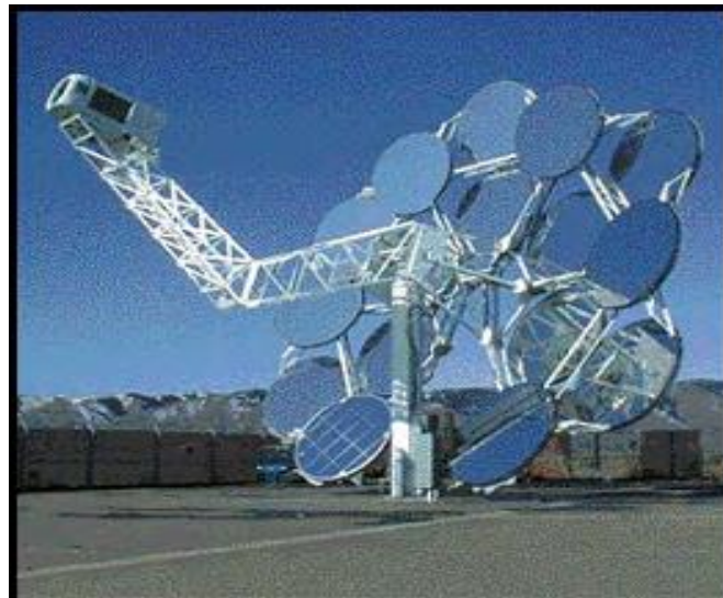
Figure 32 Un capteur à réflecteur parabolique avec un miroir et des réflecteurs du type miroir avec un absorbeur. Source : SunLabs - Department of Energy.Canada
