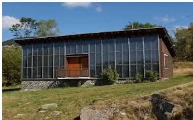
Figure 29: exemple de mur trombe, source :ww.pinterest.jp
