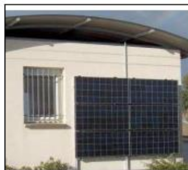
Figure 60: Intégration des capteurs solaires sur les allèges Source : Guide régional pour l'intégration architecturale Des capteurs solaires
