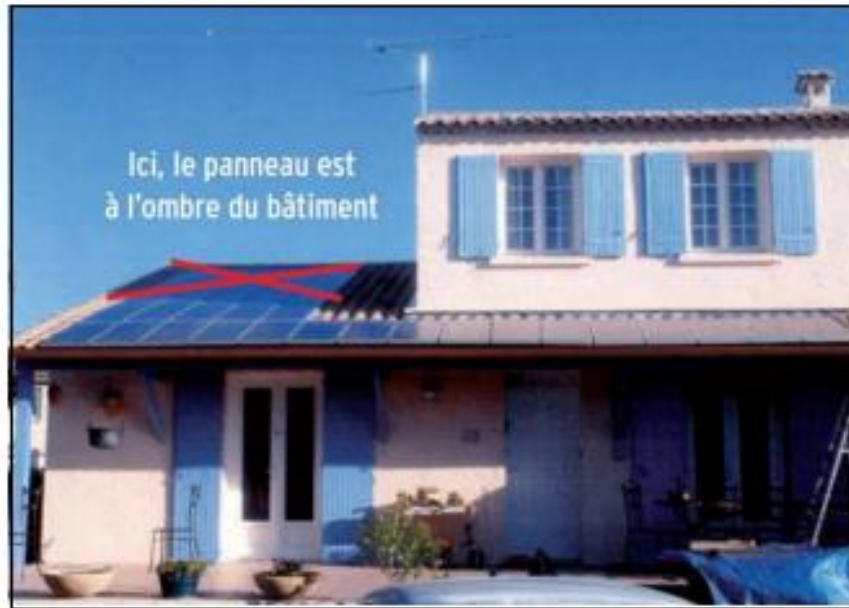
Figure 51: Figure : Installation du capteur PV dans un endroit masqué Source : M. BENAMRA (Mostefa Lamine) : Intégration des systèmes solaires photovoltaïques dans le bâtiment : Approche architecturale, Université de BISKRA, 2013
