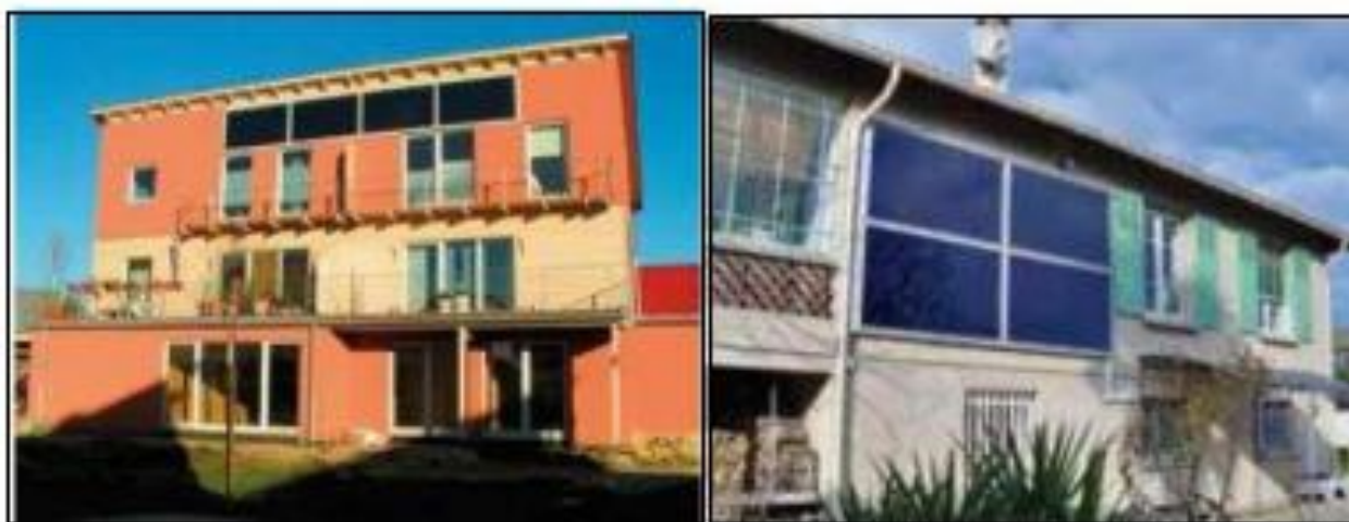
Figure 64:Exemple d'installation des capteurs solaires sur la façade comme composant architectural Source Guide régional pour l'intégration architecturale des capteurs solaires
