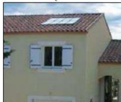
Figure 55: Installation du capteur sur une toiture inclinée respectant l'axe de la fenêtre Source : M. BENAMRA (Mostefa Lamine) : Intégration des systèmes solaires photovoltaïques dans le bâtiment : Approche architecturale, Université de BISKRA, 2013
