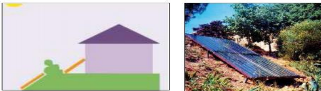
Figure 65:Exemple d'installation des capteurs solaire sur le sol.Source : Guide régional pour l'intégration architecturale des capteurs solaires
