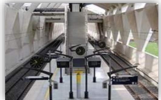
Figure 95: Les quais de la gare de Satolas. Source : www.googleimage.com
