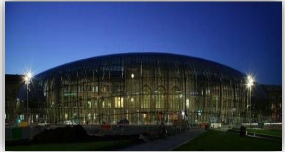
Figure 99: La verrière du pôle d'échange multimodale de Strasbourg.
