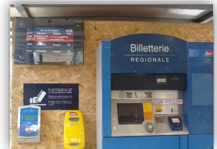
Figure 107: Les billetteries de la gare de Saint-Marcel.
