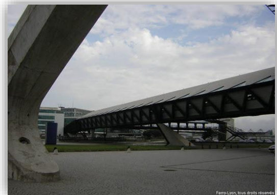
Figure 93: Passerelle de la gare de Satolas. Source : www.googleimage.com
