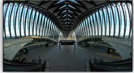
Figure 91: Hall central de la gare de Satolas. Source : www.googleimage.com
