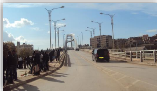
Figure 70: Accès sud-ouest vers RN 16, RN 81. Source : l'auteur, 2019.
