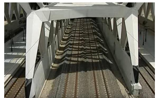
Figure 96: Le tube 300 Les quais, la gare de Satolas. Source : www.googleimage.com
