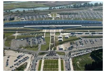
Figure 109: Les parkings de la gare des d'Avignon.
