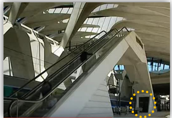
Figure 90: Circulation verticale dans la gare de Satolas. Source : www.googleimage.com
