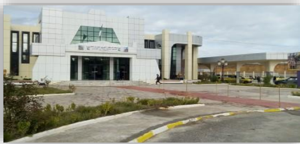
Figure 63: Gare routière de Souk Ahras.
