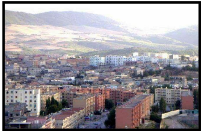
Figure 57: vue panoramique du site étudié ; source auteur.
