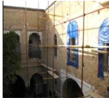
Figure 25 : Travaux de décapage des murs
