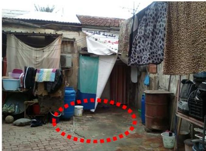
**Figure 59: Détérioration du pavage au niveau du patio**
