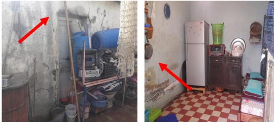
**Figure 58 : L'humidité au niveau des murs du patio et la cuisine**
