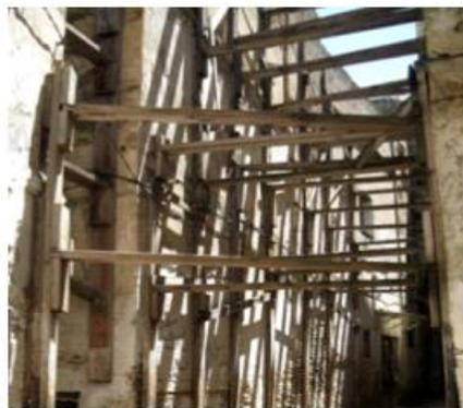
Figure 22 : Travaux de consolidation et D'étayage de vieilles maisons menaçant ruine
