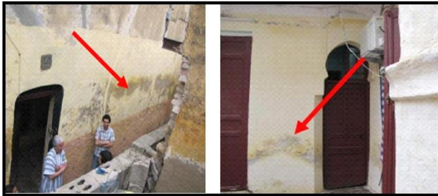
**Figure 47 : Traces d'humidité dans les murs intérieurs et extérieurs**
