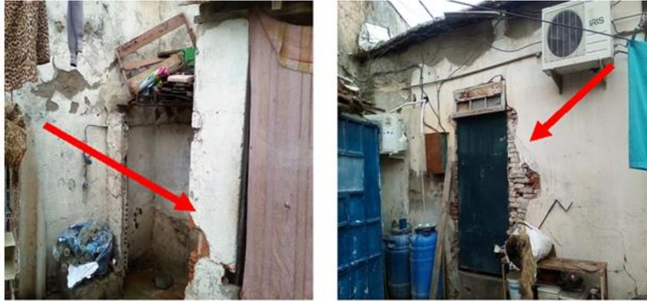
**Figure 57 : L'état de dégradation des enduits au niveau maison**
