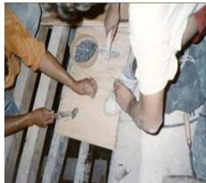
Figure 21 : Assemblage et clouage de plaques en bois Sur les solives
