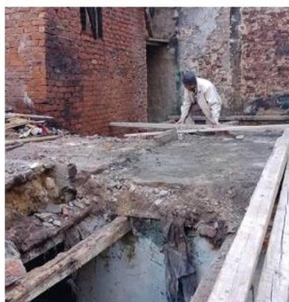
Figure 17-18 : Réfection des murs endommagés      Figure 18: Réfection d'un plancher
