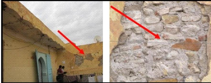
**Figure 48 : L'état de dégradation des enduits extérieurs de la maison**
