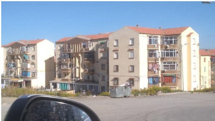
Figure 84 bâtiment en moyen état
