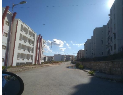
Figure 82 bâtiment en bon état
