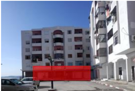
Figure 80 : locaux commerciaux au niveau des bâtiments
