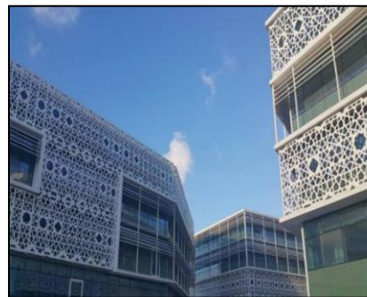
Figure N°60 : Façade de CMF
