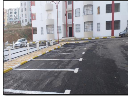
Figure N° 33: Vue sur stationnement
