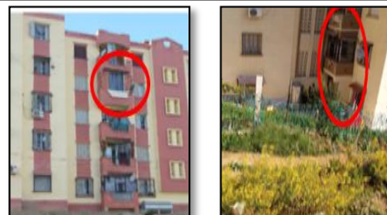
Figure N°37 : Modifications au niveau de la façade
