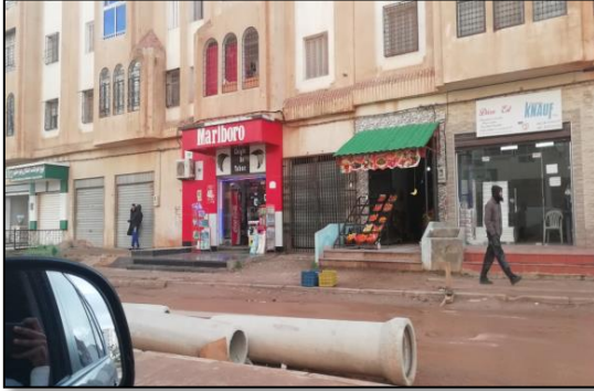
Figure25 : revêtement de sol
