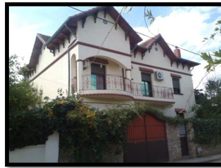
figure 52 : maison transformation R La source Appareil photo
