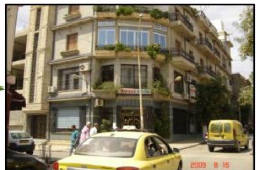
figure 27 : l'immeuble commercial en : 2010
