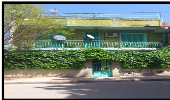
Figure 49 : Construction récente Source : hauteur 2020
