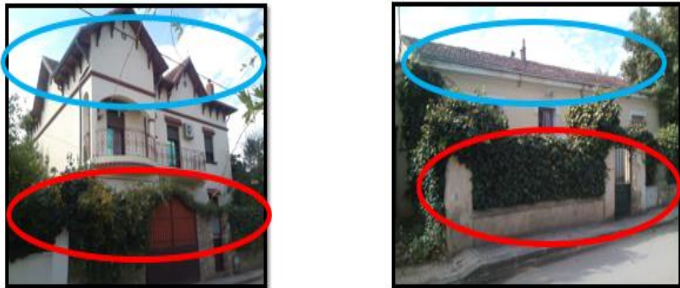
Figure59 : Transformation au niveau des façades pour l'esthétique
