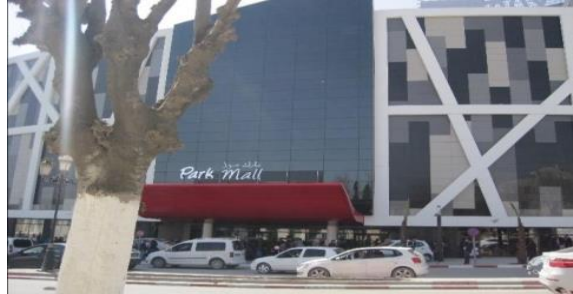
Figure 60 : accès Park Mall Sétif
