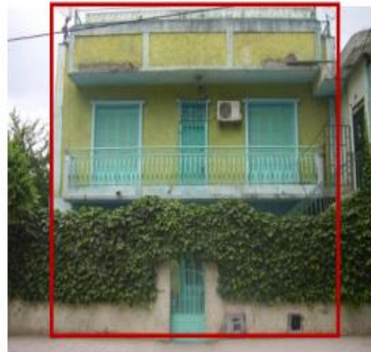
photo 57 : la façade principale de la maison
