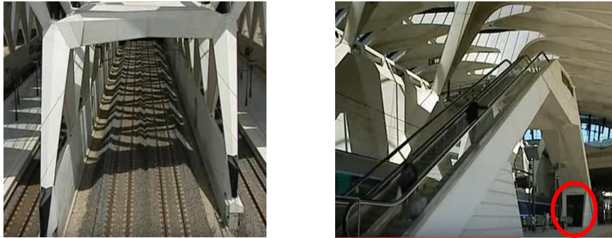
Figures 56 : le sous-sol de la gare
