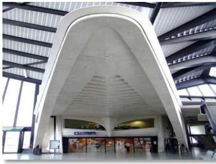
Figure 71 : la structure en porte-à-faux
