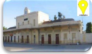
Figure 131 : Gare ferroviaire source : prise par l'auteur
