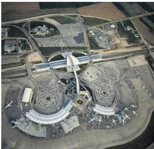
Figure 47 : Vue aérienne de l'ensemble la gare
