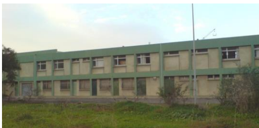
Figure 19 Vue sur les locaux techniques.
