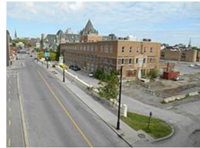
Figure 1 vue sur le batimern de la gare viger
