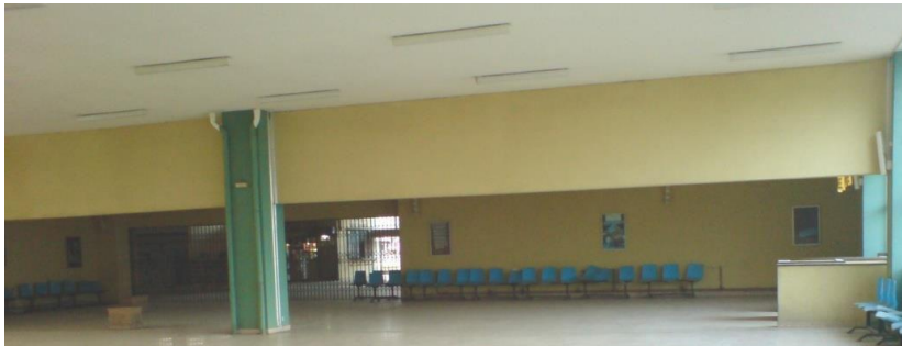
Figure 21 Retombée de poutres.
