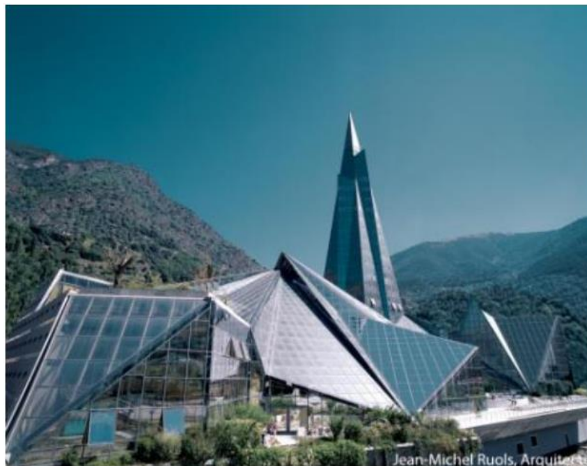
Figure 57 : centre thermo ludique Caldea
