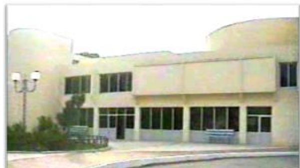
Figure 19 : accès au personnel administrative
