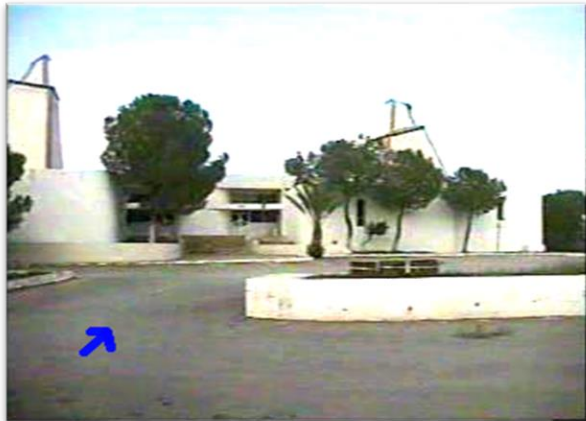
Figure 17 : voie mécanique menant vers le bloc thermal
