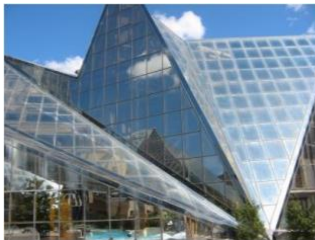
Figure 60 : revêtement des façades du centre Caldea
