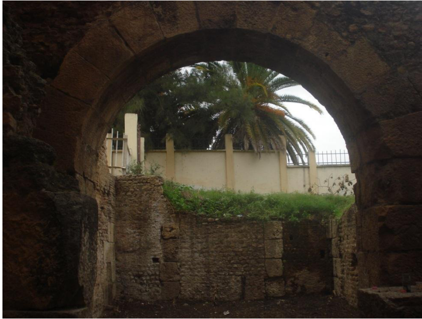
صورة لبقايا الجدار الشمالي للحمامات المبني باستعمال التقنية المختلطة.
