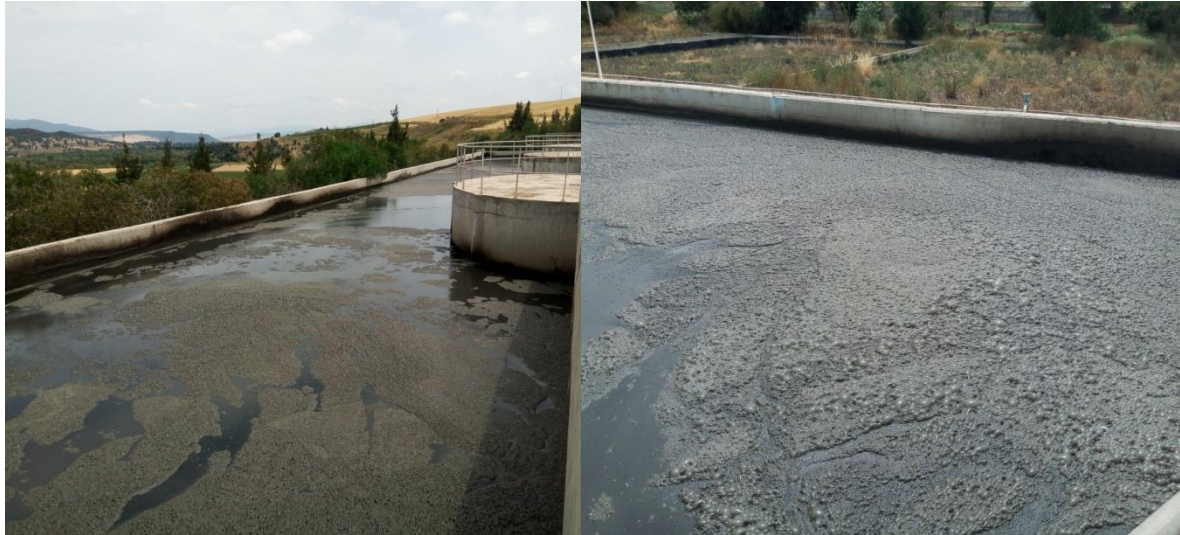
Figure 16 : Le bassin de stabilisation des boues (Prise personnelle).
