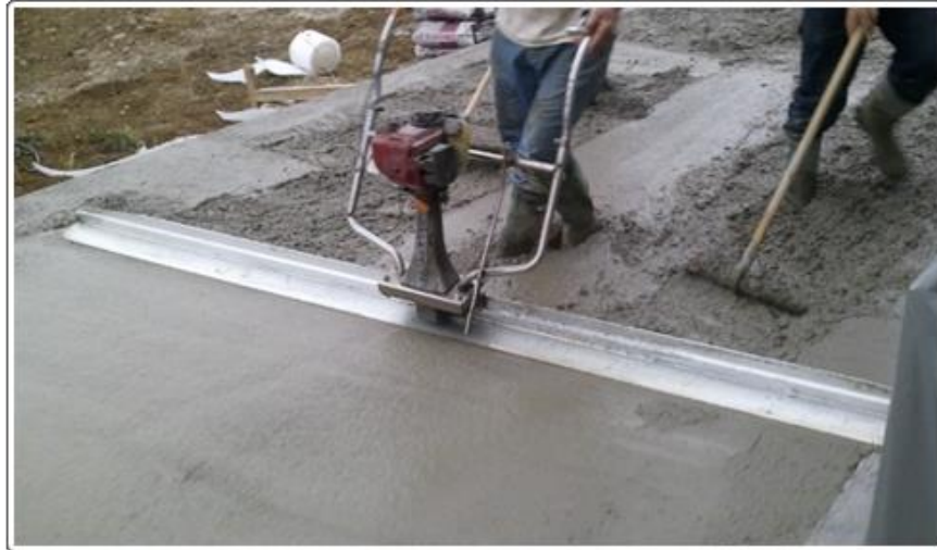
Fig.6.13. Photo d'une règle vibrante pour dallage et planchers.
