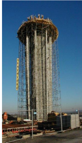
Fig.6.4. Mise en place de l'échafaudage
