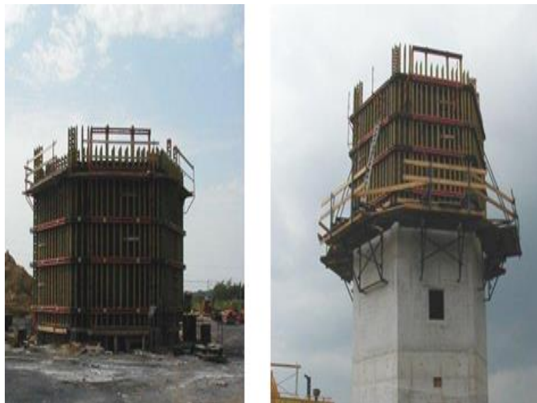
Fig.6.5. Coffrage grimpant
