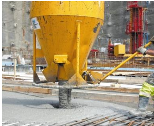
Fig.8.2. Coulage d'une dalle en BAP.
