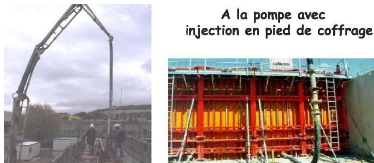
Fig.8.3. Exemples de mise en œuvre des BAP.
