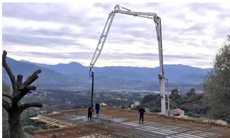
Fig.6.9. Mise en œuvre du béton pompé
