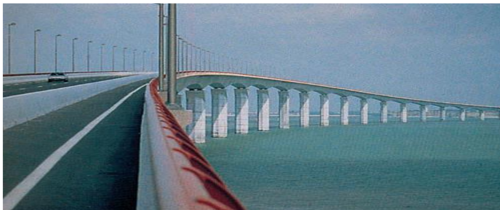
Fig.8.12. Un pont réalisé en béton à haute performance.
