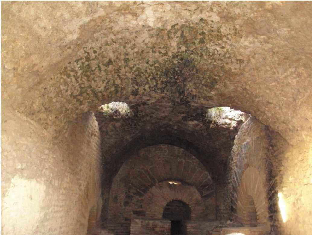
الصورة رقم 7 : جزء من الملاط المستعمل في تلبيس جدران الحمامات
