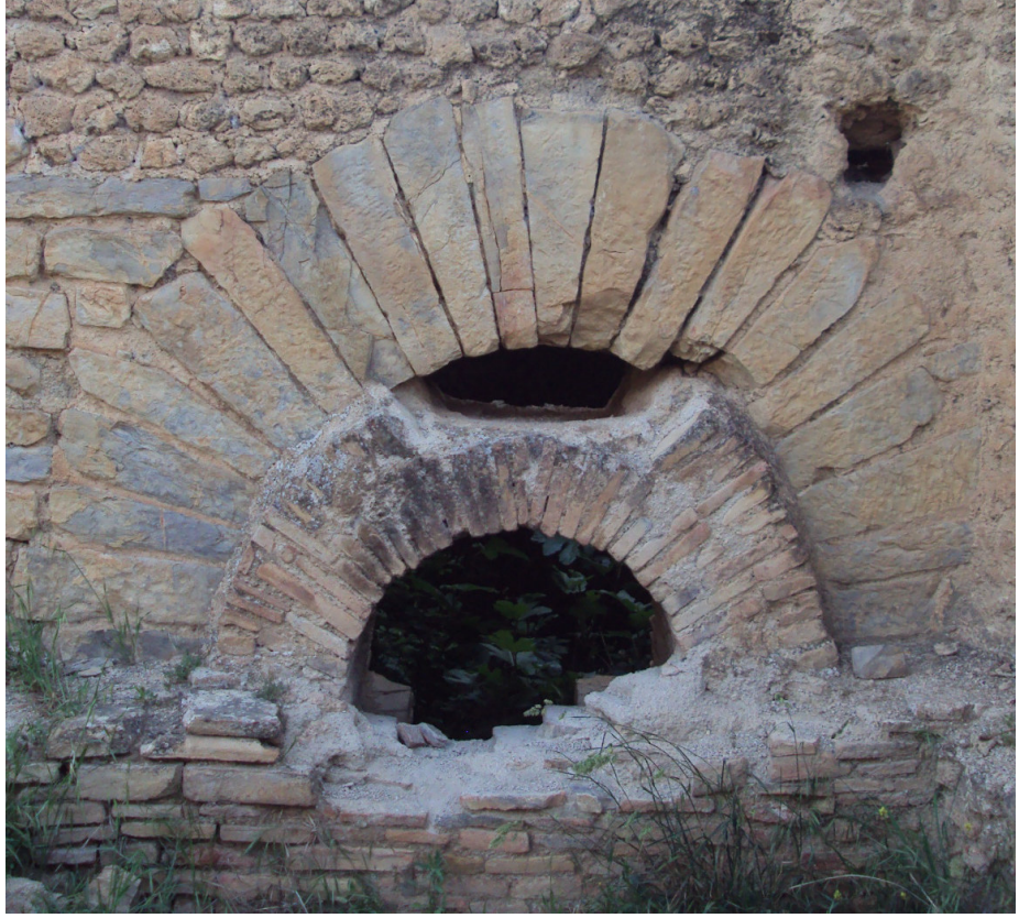
الصورة رقم 17 : قوس مبني بالآجر ومدعم بحجارة مسطحة لإحدى أفران التسخين
