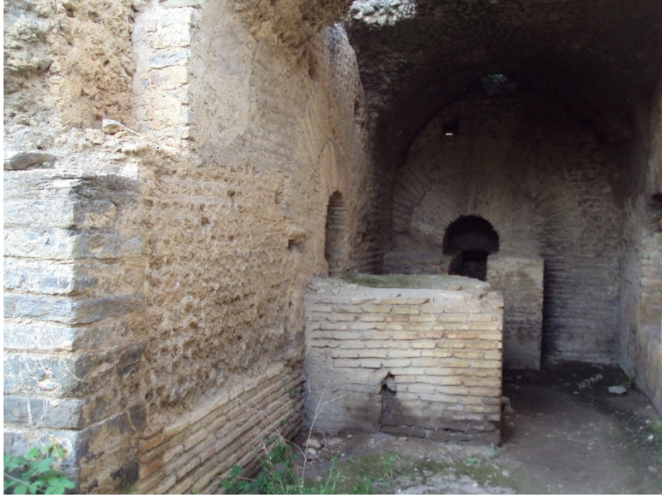
الصورة رقم 11: تقنية البناء المزدوج
