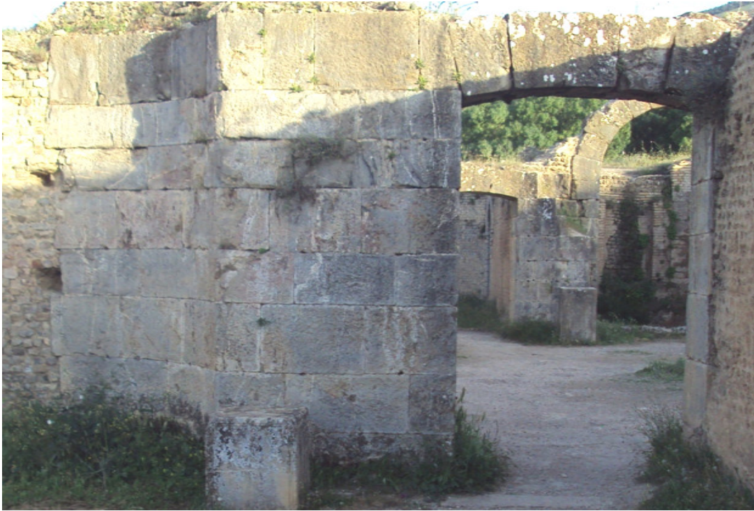
الصورة رقم 9 : تقنية البناء بالحجارة الكبيرة في الحمامات الكبرى الجنوبية
