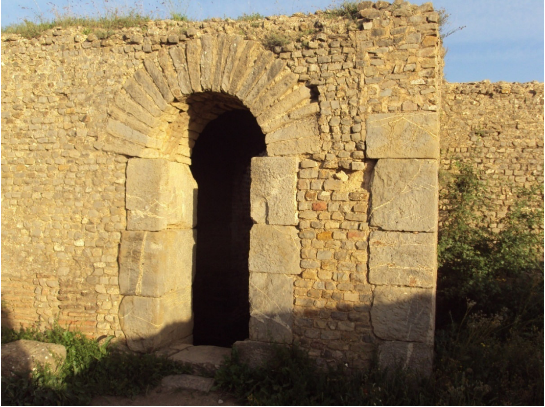
الصورة رقم 15 : قوس مبني بالحجارة المسطحة
