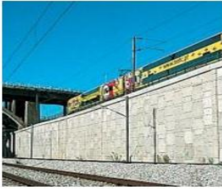
a : ouvrages ferroviaires
