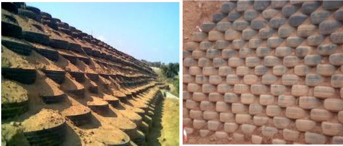
Fig. II.13 Mur en pneu sol.
