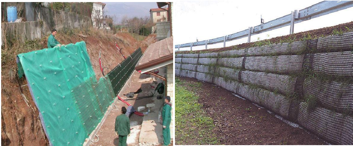
Fig. II.15 Exemple de géo grille sol.
