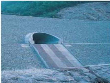
c : ouvrages hydrauliques
