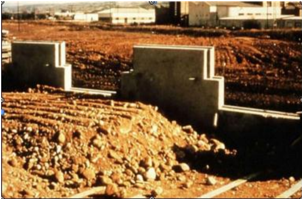
Fig. II.11 Mur en terre armé.
