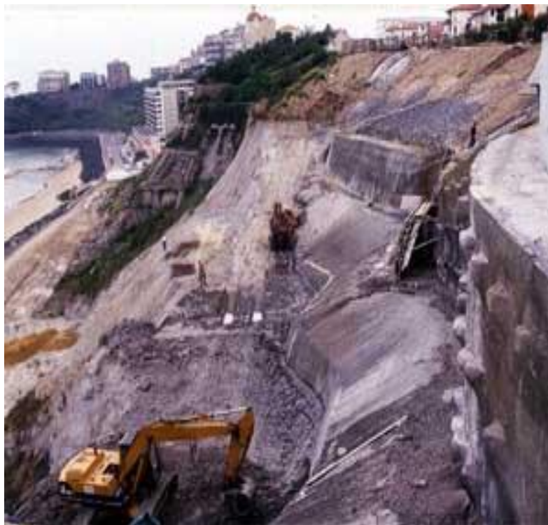
Fig. I.11. Les travaux de terrassements
