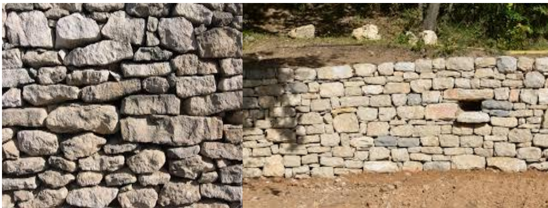
Fig. II.3 Mur en pierres sèches
