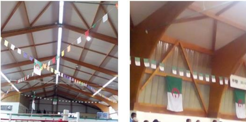
Figure II. 1 : Salle de sport à Tamanrasset (en bois lamellé collé).
