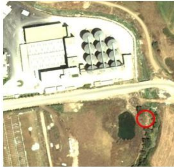
Figure VI.3. Rejet des eaux pluviales de la minoterie Ben Amor
