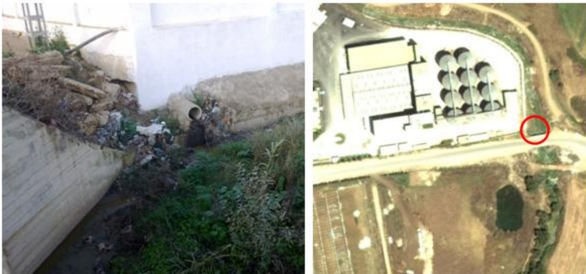
Figure VI.2. Photos de rejet des eaux domestiques de la minoterie Ben Amor
