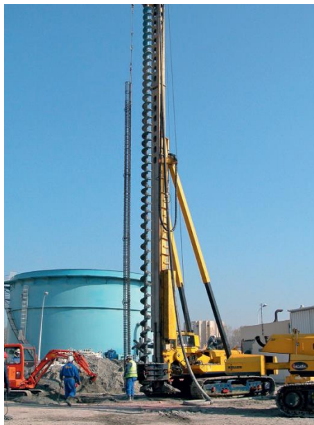
Figure VI.4: Photo d'une tarière en cours de travaux.
