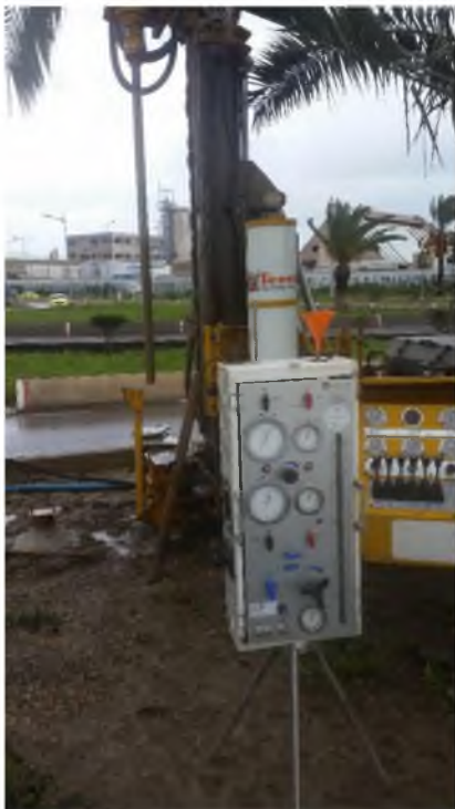
Figure 4.3 Essai de la sonde en air
