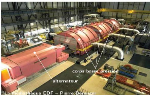
Figure 2.2 - Salle des machines de la centrale nucléaire de Flamanville (Manche)
