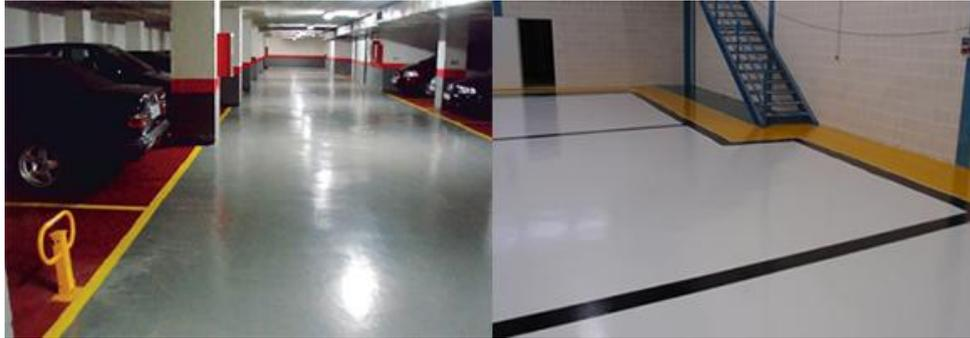
**Fig. I.3 :** Un revêtement protecteur époxydique polymère, polyuréthane ou acrylique. [5]
