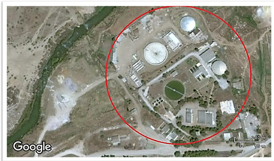
Figure 2. Photo satellitaire de la station de traitement des eaux brutes du barrage de Hammam Debagh (Google Earth, 2018).
