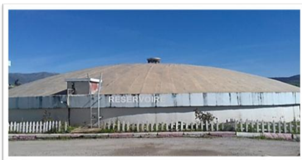
Figure 22. Réservoir de stockage (Auteur).
