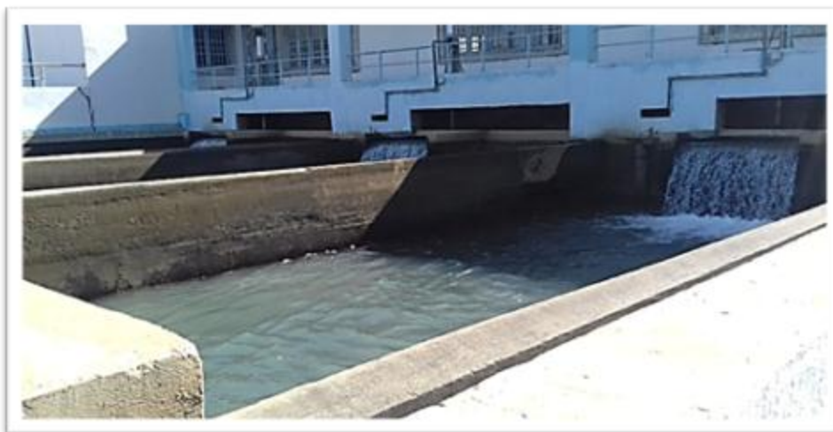
Figure 21. Bassin de la filtration (Auteur).
