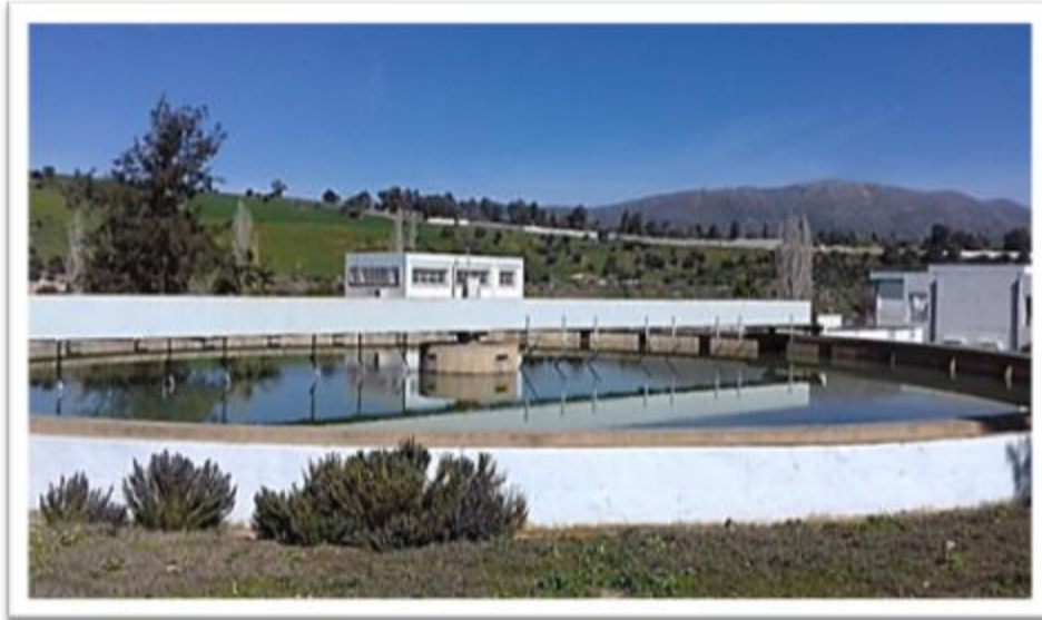
Figure 20. Bassin de décantation (Auteur).
