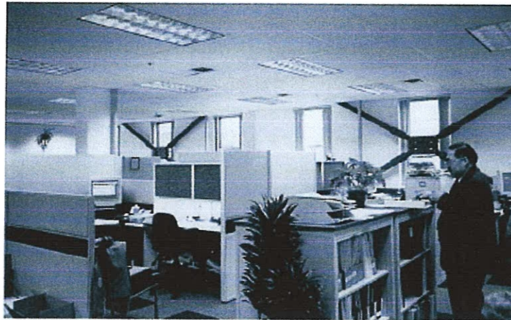
Figure 1.21 Amortisseurs à friction installés.
