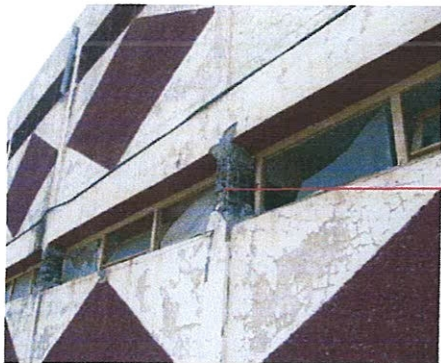
Cisaillement des poteaux courts sur la hauteur des fenêtres. Séisme du 21 Mai 2003 en Algérie
