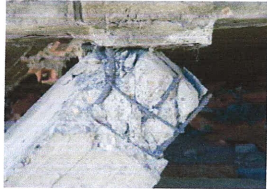
Insuffisance d'armatures transversaux, béton de mauvaise qualité, rupture au droit de la surface de reprise
