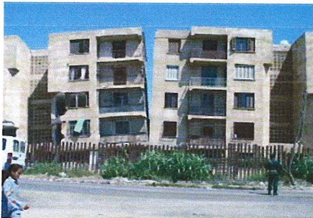
Ouverture des bâtiments vers le haut après entrechoquement.
