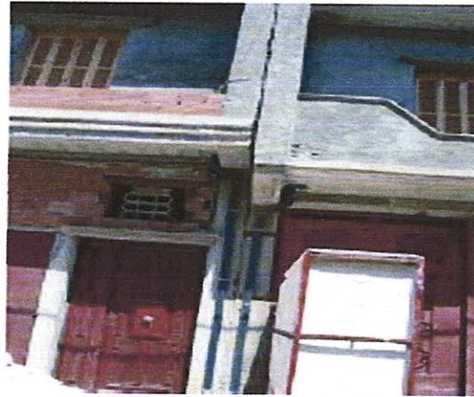
Absence de joint entre les bâtiments.
