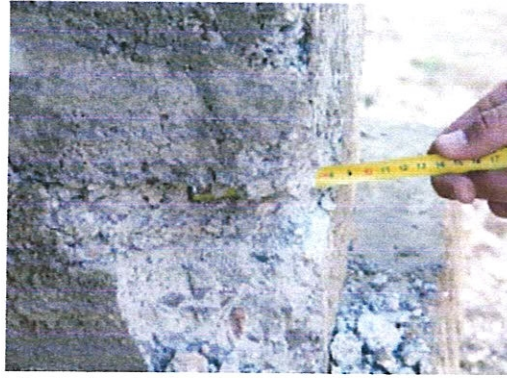
Talonnette et enrobage des armatures de 8 cm au lieu de 2 cm
