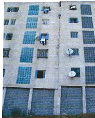
Joint de 2 cm remplis avec du polystyrène.
