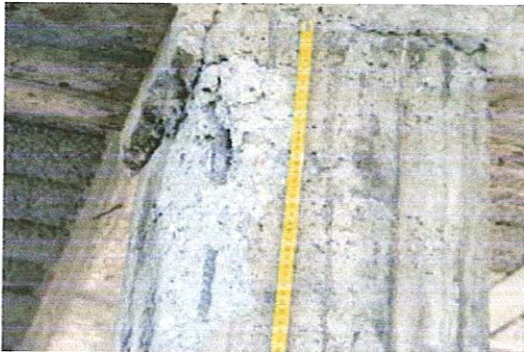
Béton de mauvaise qualité, absence d'armatures dans la zone critique, talonnette de 6 cm
