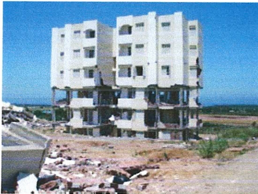
Entaille au centre du bâtiment et sur toute la hauteur.
