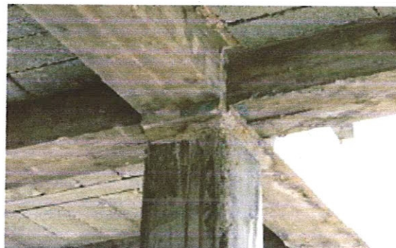
Béton de mauvaise qualité, présence du papier en dessous de la talonnette de 6 cm
