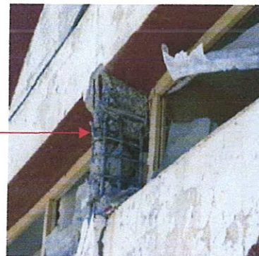
Cisaillement des poteaux courts sur la hauteur des fenêtres. Séisme du 21 Mai 2003 en Algérie
