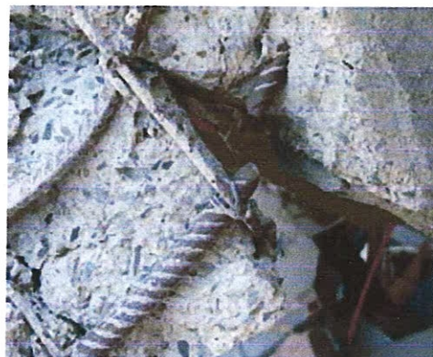
Effondrement à cause de l'absence d'armatures transversales dans le nœud et dans la zone critique du poteau
