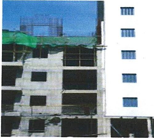
Joint de 10 cm remplis avec du polystyrène.
