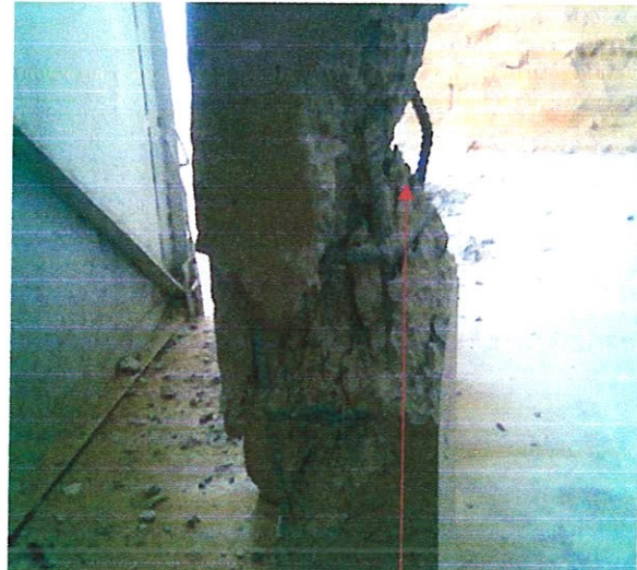
Flambement des armatures longitudinales
