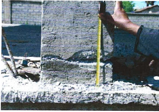
Talonnette de 10 cm en mortier de très mauvaise qualité
