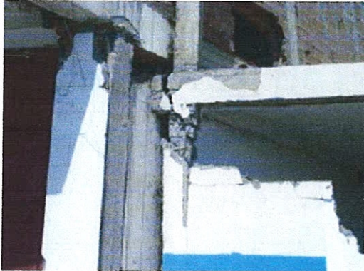
La présence de l'allège a limité le déplacement du poteau sur la hauteur libre et a provoqué son endommagement.
