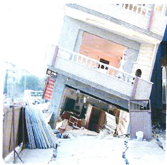
Cas2 : Poinçonnement de la fondation suite à la liquéfaction du sol (séisme du Turquie "Kocaeli" en 17 août 1999).
