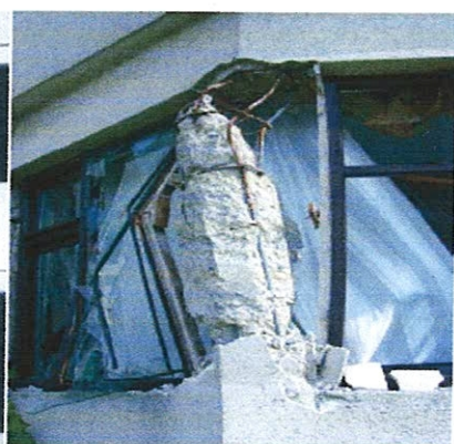
Cisaillement des poteaux courts sur la hauteur des fenêtres. Séisme du Turquie en 1999
