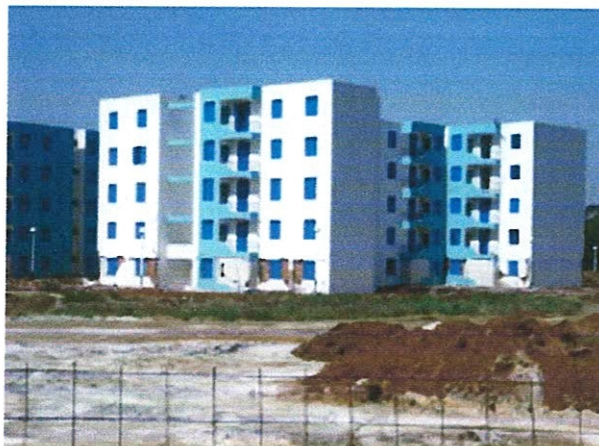
Entaille au centre du bâtiment et sur toute la hauteur.
