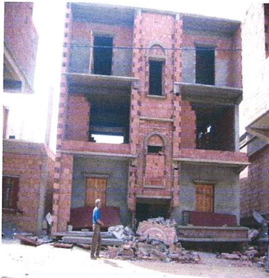
Cas1 : Affaissement de la fondation suite à la liquéfaction du sol (séisme du 21 mai 2003 en Algérie).
