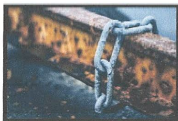
Figure II.1 : Exemple de Corrosion d'un matériau
