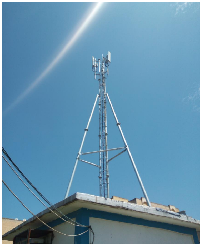
Figure 5.4 : Pylône de Boumahra.
