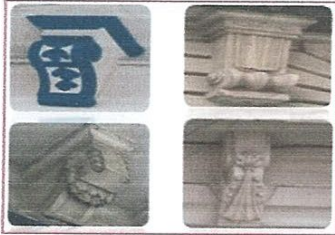
Figure N° 35 : Les consoles Elles sont en plâtre
