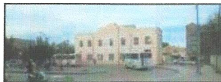
Figure 52: Stationnement des bus a la gare. Source : auteur 2016.
