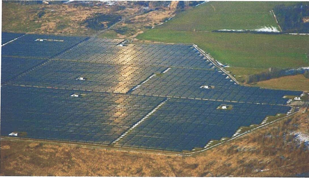
Figure. III.8. Vue de la centrale solaire photovoltaïque de Brandis (Allemagne) ( P_c = 40 MW).
