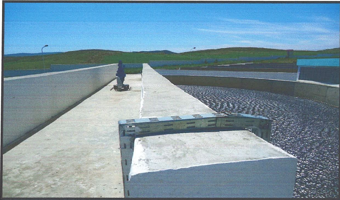
Photo I.18 : Le bassin d'épaississement (épaisseur)
