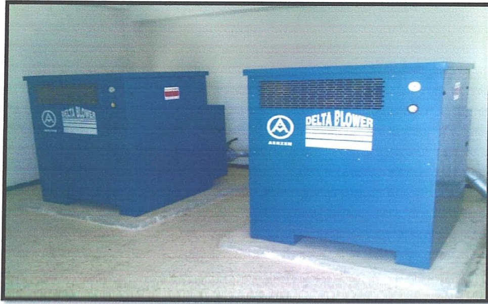
Photo I.7 : Les supprimeurs d'aire (a piston)
