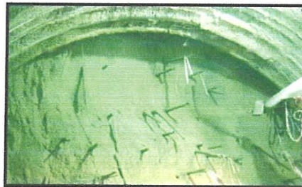
Photo 3.12 : la projection du béton projeté au front de taille
