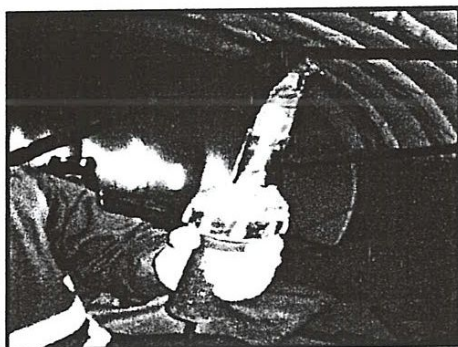
Photo 4.22: la fixation de la Géotextile (par split) et la Géomembrane (par rondelle)
