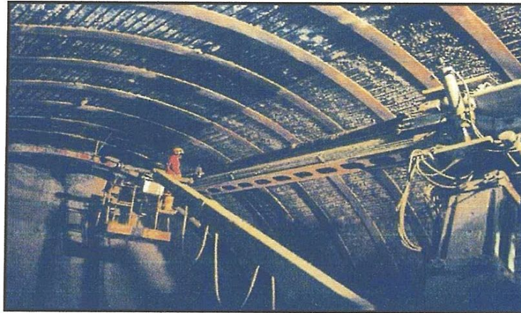
Photo 3.11 : Soutènement par cintres
