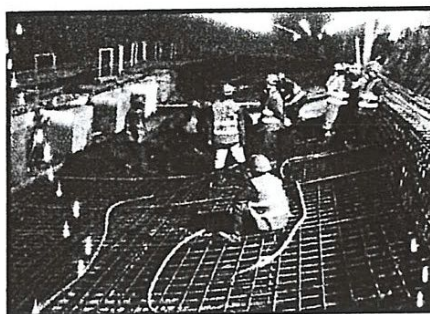
Photo 4.27: coulage de radier (La première demie section)
