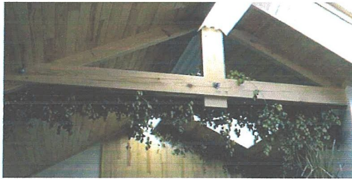
Figure 4-6: assemblage par boulon
