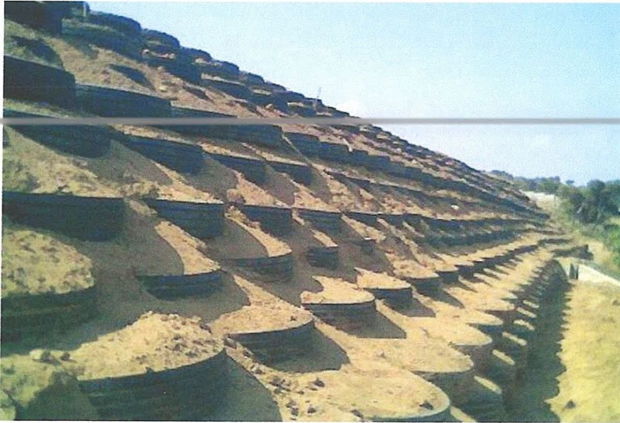
Figure 3 : Chantier expérimental Pneu sol à Bou-Ismaïl Tipaza
