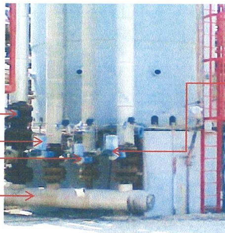
Figure 5.3 : les vannes et les conduites des quenches
