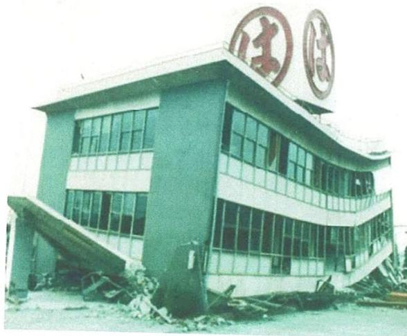
Il faut veiller à ce que la distribution des espaces et le choix de leurs enveloppes ne créent pas de noyaux rigides excentrés. Dans le cas ci-dessous, le niveau flexible du rez-de-chaussée comporte un « noyau rigide excentré (cage d'escalier). Sous l'effet des secousses, le bâtiment a subi une torsion autour de ce noyau rigide peu déformable.
