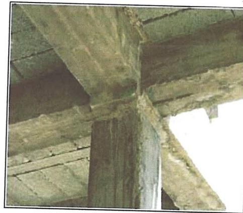
Béton de mauvaise qualité, présence du papier en dessous de la talonnets de 6 cm
