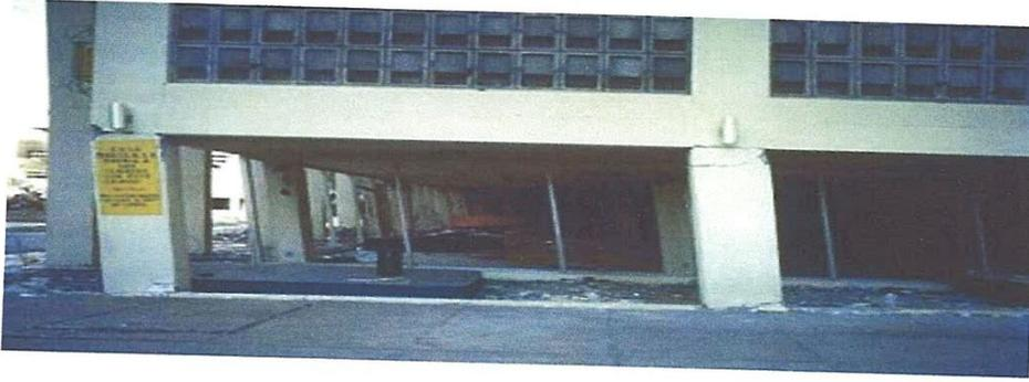
Document NISEE- USA- Ce bâtiment dont les poutres sont dimensionnées plus largement que les poteaux à eu un comportement à éviter absolument sous séisme la rupture des têtes de poteaux qui aurait entraîné la ruine totale pour des secousses plus violentes
