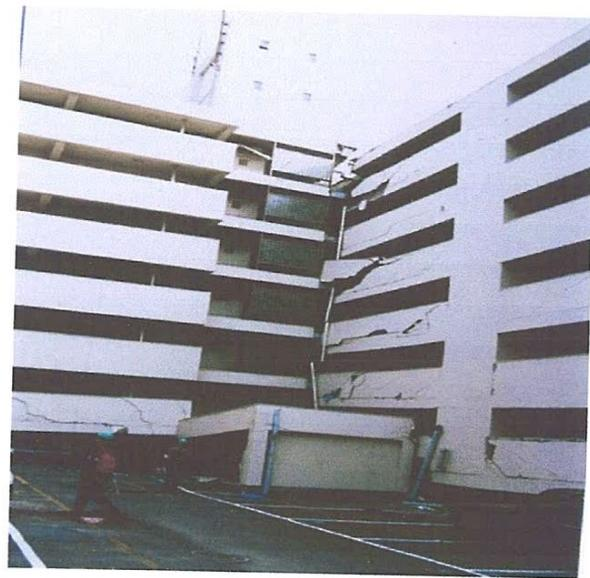
On observe également que les bâtiments qui ont une forme très allongée en plan subissent ce qu'on appelle un coup de fouet aux extrémités. Là encore il est préférable de recouper le bâtiment en plusieurs unités par un ou des joints parasismiques, ou de renforcer les extrémités
