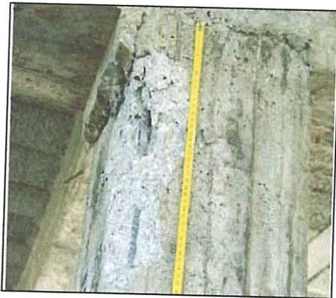
Béton de mauvaise qualité, absence d'armatures dans la zone critique, talonnets de 6 cm
