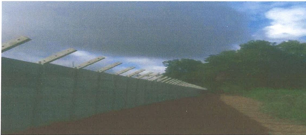
Photo 4.4 : palplanche en béton armé
