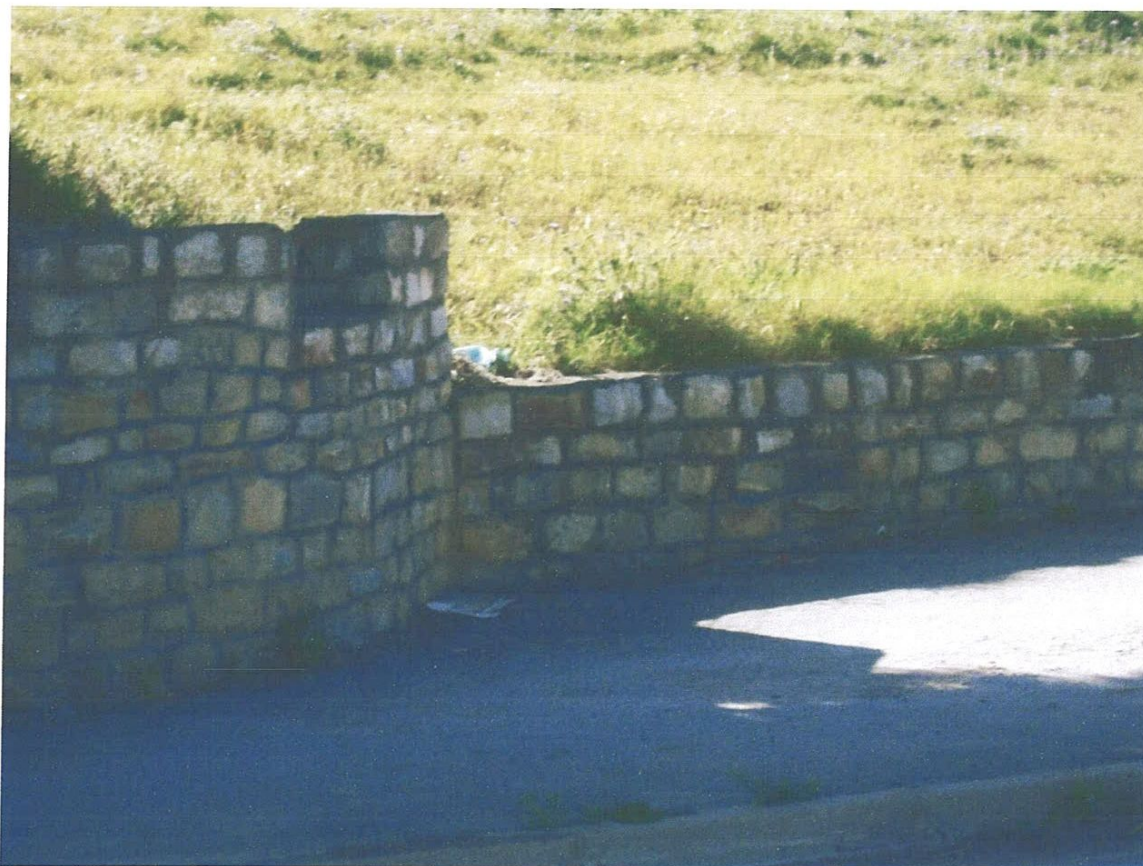
Photo 4.3 Mur en maçonnerie
