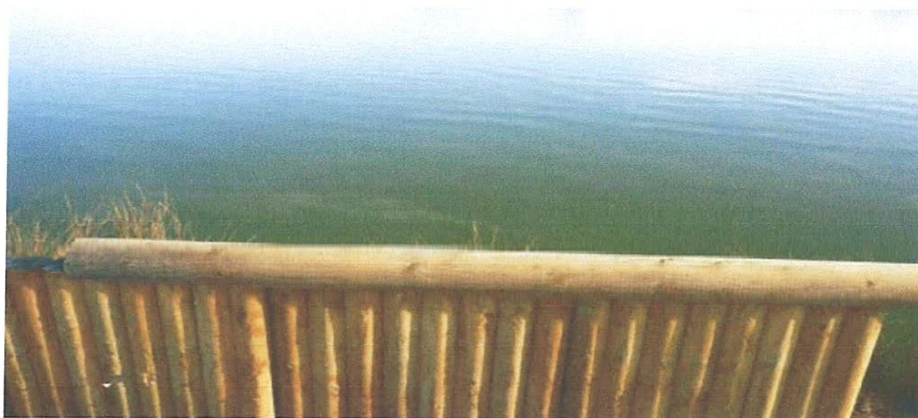
Photo 4.5 : palplanche en bois
