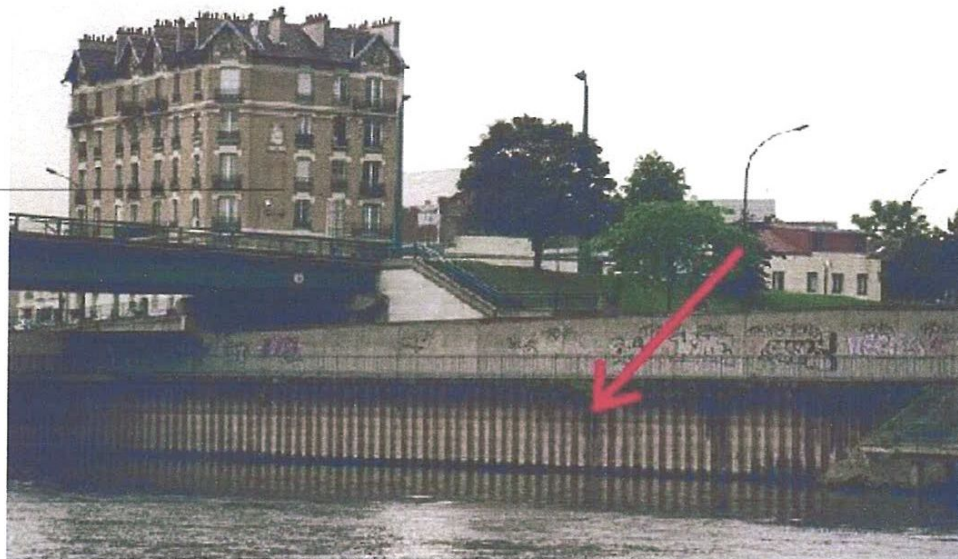
Photo 4.6. Palplanche métallique
