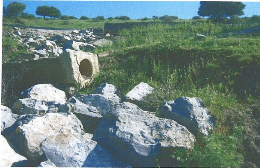
Photo3.4 pierres et vieilles conduite qui constituent une surcharge
