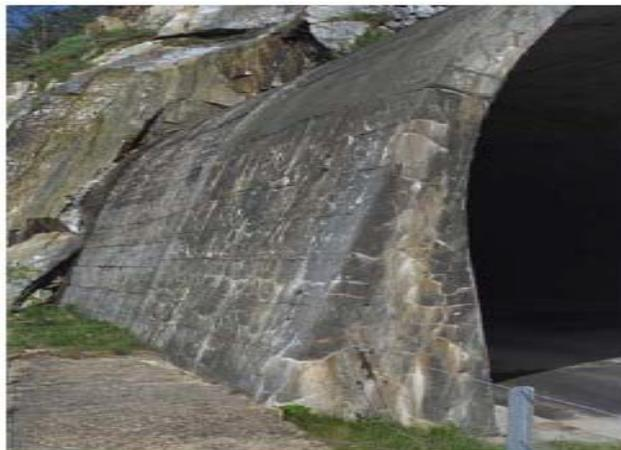
Figure I.3 : Mur d'entrée d'un tunnel atteint d'une réaction alcali-granulat [ELH-04]
