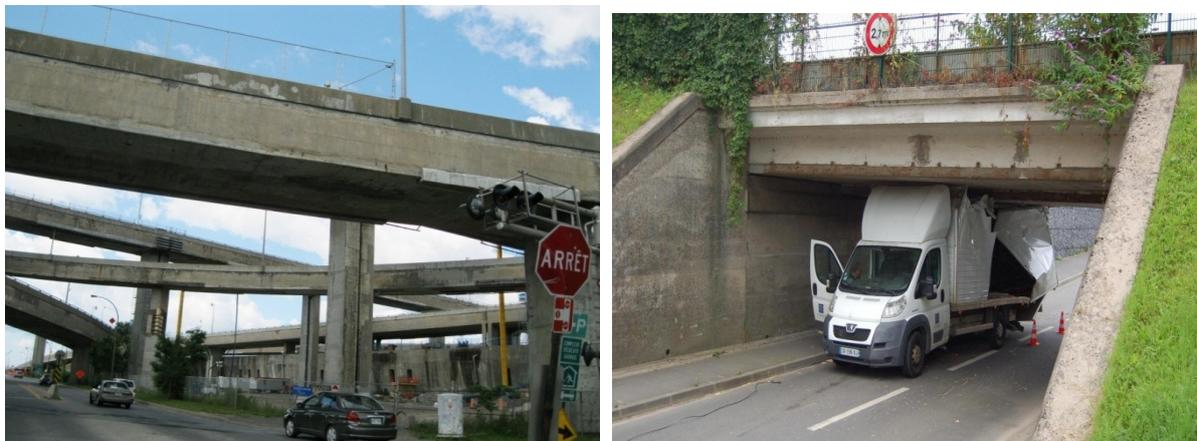
Figure I.5 : Choc sur le pont Sainte-Hélène [ELH-04].
