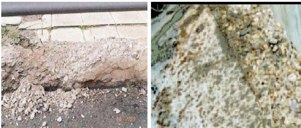
Figure I.2 : Dégradation due au gel/dégel [POI-10].
