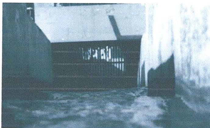
**Figure 1** : Exemple de dégrillage [2].
