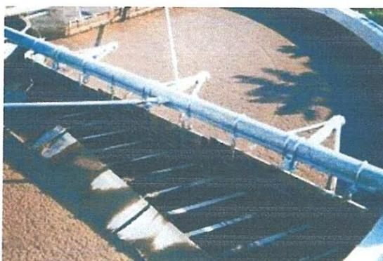
**Figure 10 :** Epaississement des boues par flottation.
