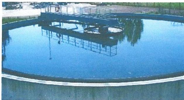
**Figure 3 :** Exemple de clarificateur [7].
