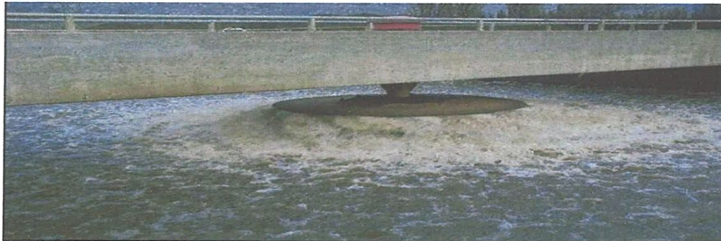
Figure 9 : Turbine de surface à vitesse lente (immersion insuffisante).
