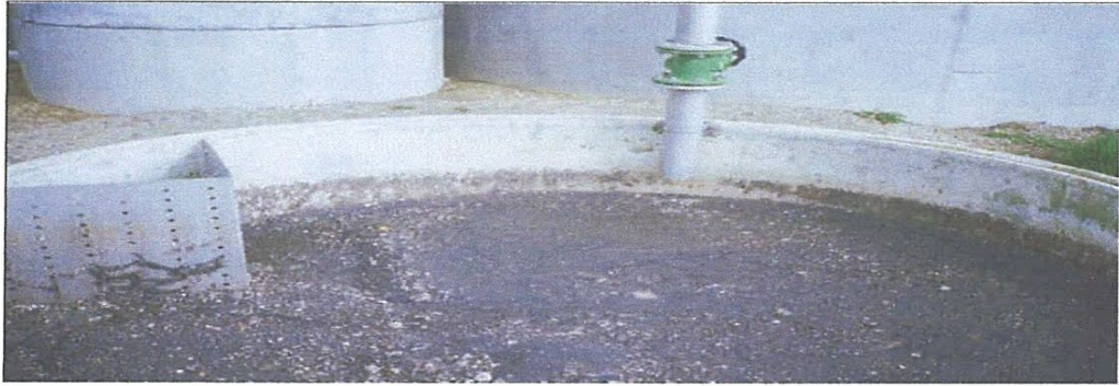
Figure 7 : Extraction du sable d'un des sableur-dégraisseur-déshuileur
