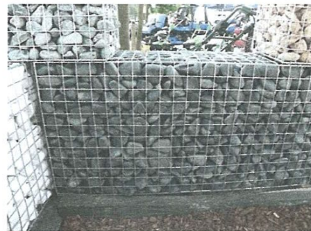
Figure 5 Mur en gabions remplies de galets
