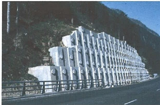
Figure 24 Voiles et poutres ancrées
