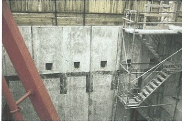
Figure 23 Parois moulées et préfabriquées
