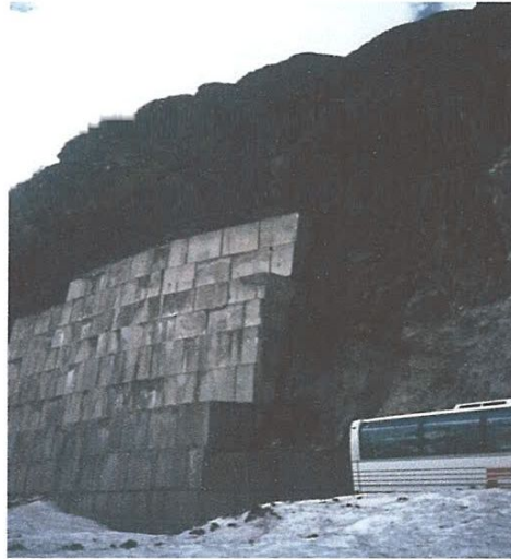
Figure 3 Mur poids en béton
