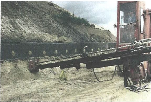
Figure 29 Forage du sol avant introduction des clous.
