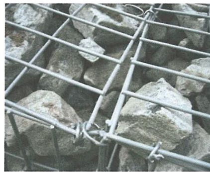
Figure 11 Agrafes entre les différents panneaux
