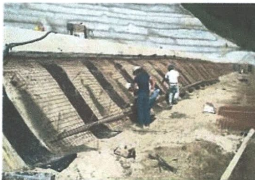
Figure 27 Mise en place des treillis soudé.
