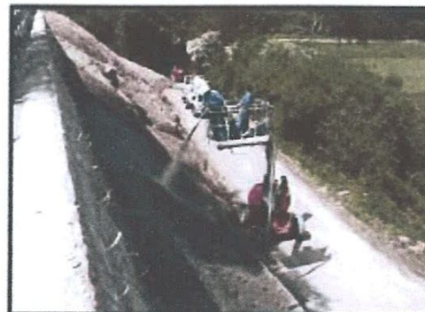
Figure 28 Mise en place du parement en béton par projection
