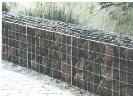
Figure 4 Mur en gabions remplies de pierres.
