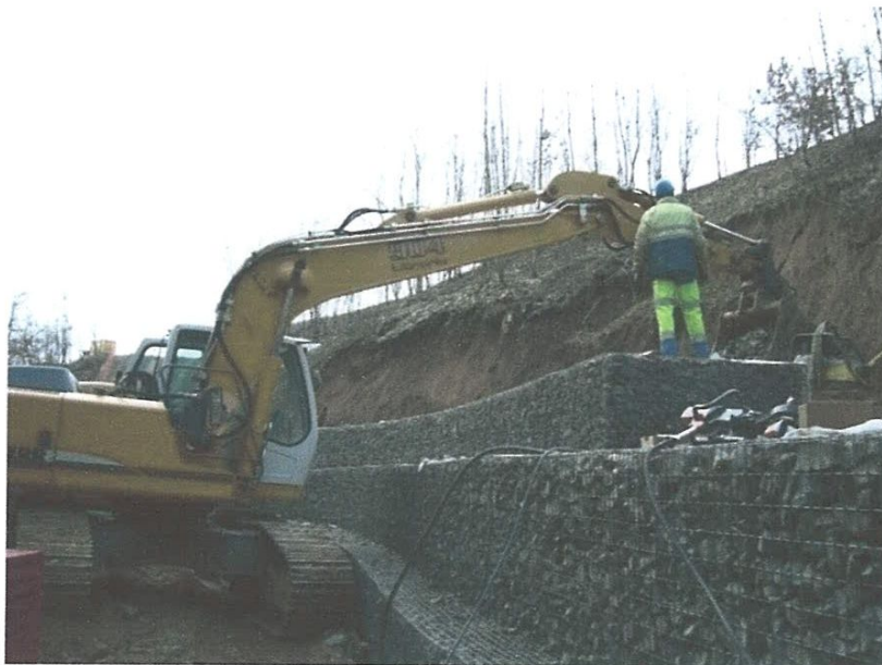
Figure 12 Tractopelle remplissant les gabions
