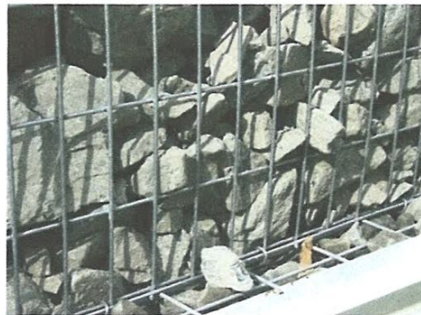
Figure 8 Gabions électro soudés
