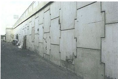
Figure 31 Mur en remblai renforcé par des éléments métallique.
