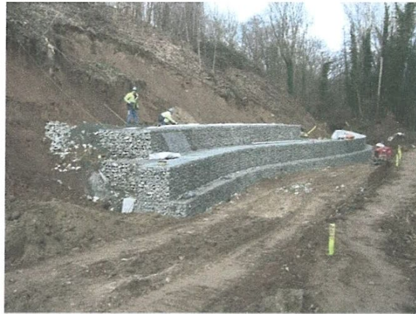
Figure 6 Chantier en cours de réalisation utilisant le technique gabion
