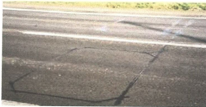
Figure 2.1. Photographie d'une boucle électromagnétique
